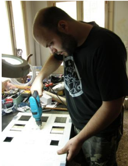
Εικόνα 3: Άνοιγμα τρυπών με τη χρήση δραπάνου
