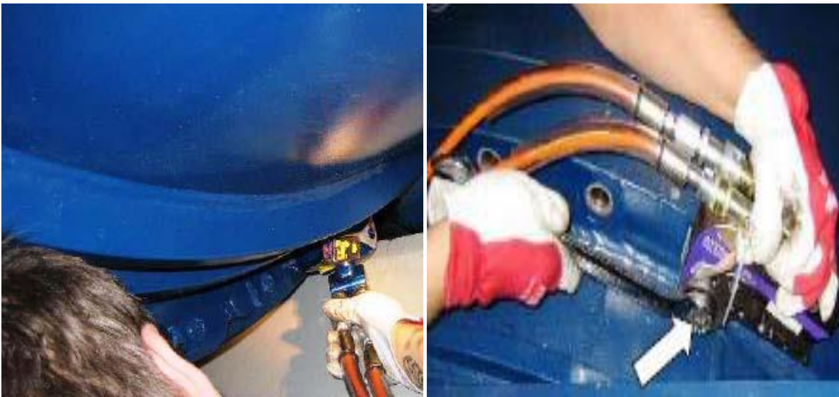
Φωτογραφίες κατά την διάρκεια χρήσης του δυναμόκλειδου σε σημεία της ανεμογεννήτριας.
