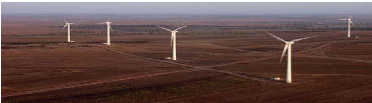
Σχήμα 2.3 : Αιολικό πάρκο σε ανοικτή και επίπεδη περιοχή, με τις Α/Γ απλά τοποθετημένες
