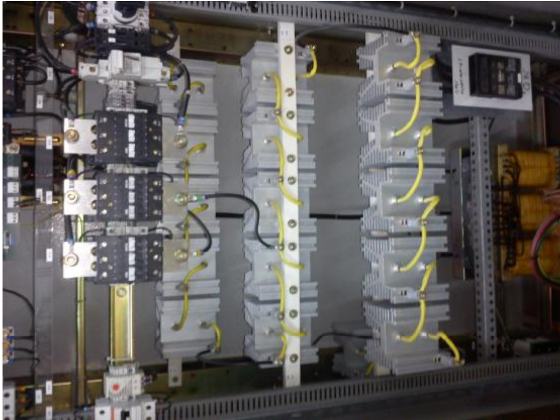
Εικόνα 8.5 Thyristors τα οποία ανορθώνουν την τάση για την παραγωγή συνεχούς ρεύματος των μπαταριών
