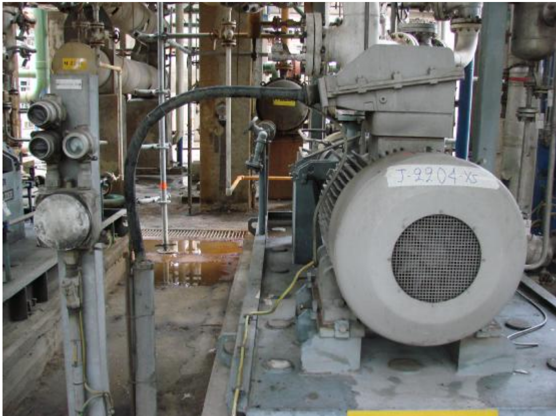
Εικόνα 10.2 Αντλία 380volt με controls στα αριστερά τα οποία ελέγχονται από τον υπεύθυνο χειριστή
