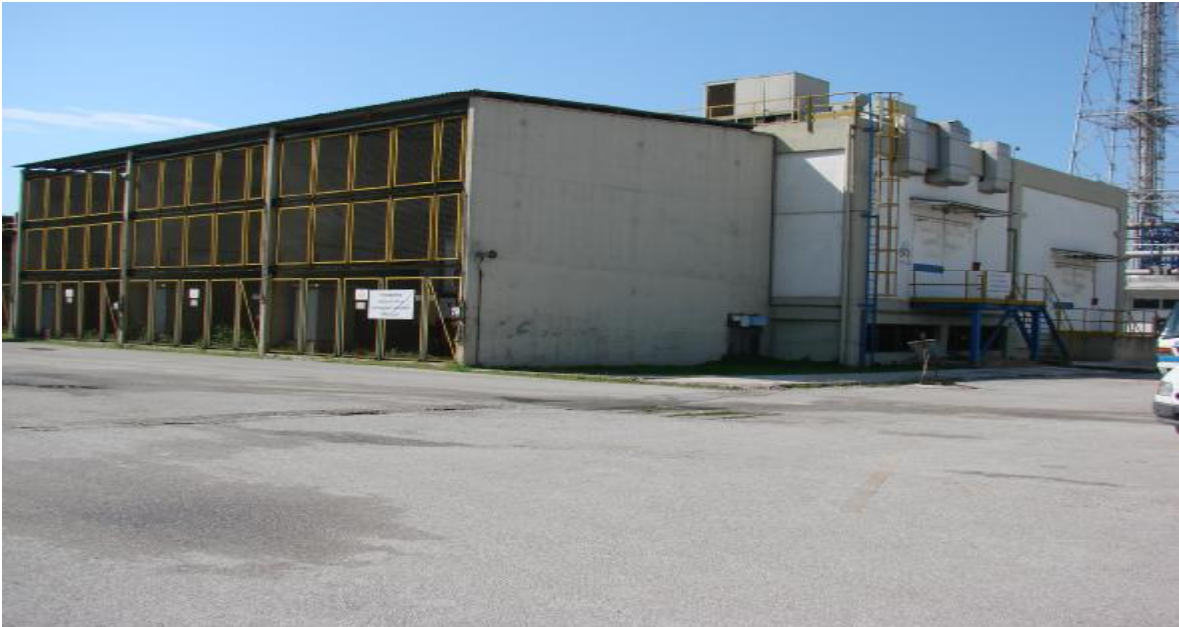
Εικόνα 3.2.1 Εξωτερική όψη υποσταθμού 7000
