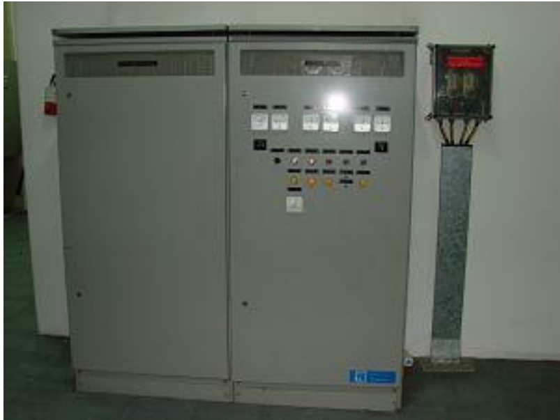
Εικόνα 8.2 Ανορθωτικές διατάξεις φόρτισης συσσωρευτών με ταυτόχρονη τροφοδότηση κυκλωμάτων ελέγχου με 110 V DC (Battery Chargers).
