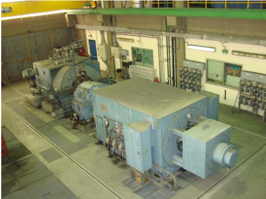
Εικόνα 7.2.4 Η γεννήτρια G2 αποτελούμενη από τα 3 κύρια κομμάτια της στα δεξιά την κύρια γεννήτρια στην μέση τον μειωτήρα και αριστερά την κύρια μηχανή του ατμού
