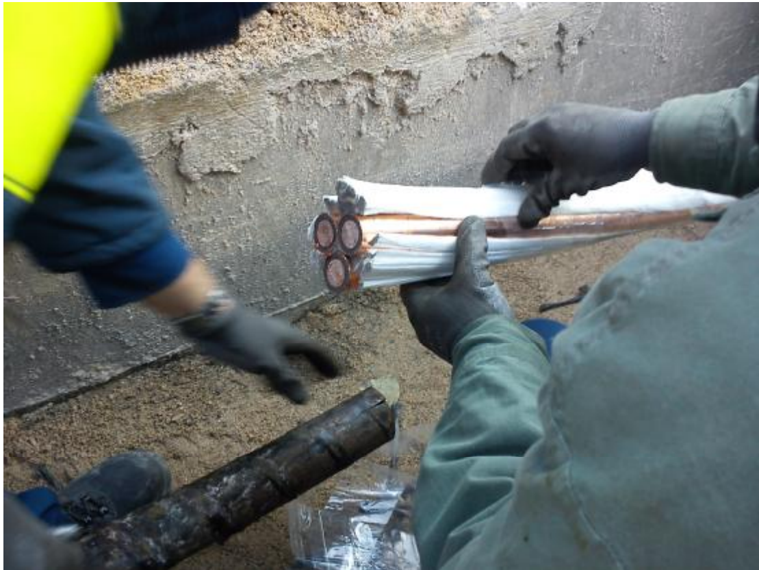
Εικόνα 4.1.3 Καλώδιο NAKBA (χαρτί με μηχανική ενίσχυση) 3X6KV/Φάση
