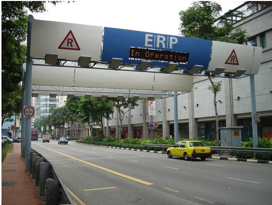
Εικόνα 6.30 Ηλεκτρονική τιμολόγηση δρόμου (Electronic Road Pricing ή ERP) στην περιοχή North Bridge Road της Σιγκαπούρης, ένα παράδειγμα ηλεκτρονικής είσπραξης διοδίων και [http://en.wikipedia.org/wiki/Electronic_Road_Pricing και http://en.wikipedia.org/wiki/Electronic_toll_collection#Technologies ].
