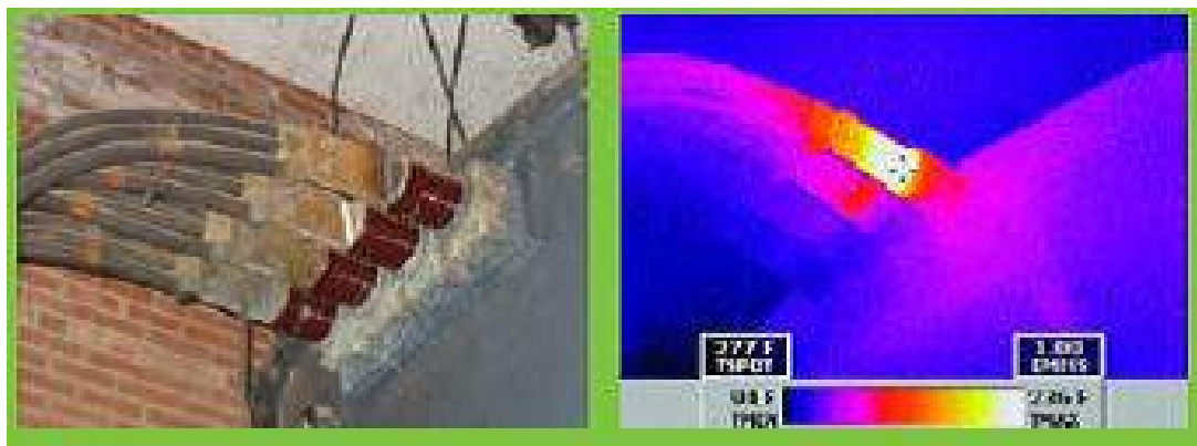
Εικόνα 27: Ακροδέκτες μετασχηματιστή σε συμβατική και θερμική απεικόνιση – παρατηρείται υπερθέρμανση σε έναν από τους ακροδέκτες
