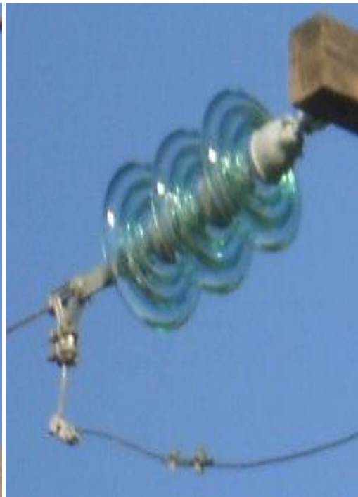
Σχ.(2.2.5): Μονωτήρας τέρματος
