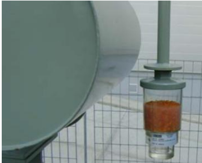
Σχ. (5.8.9): Αφυγραντήρας ή Silicantzer
