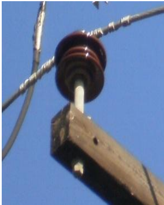
Σχ.(2.2.4): Μονωτήρας ευθυγραμμίας
