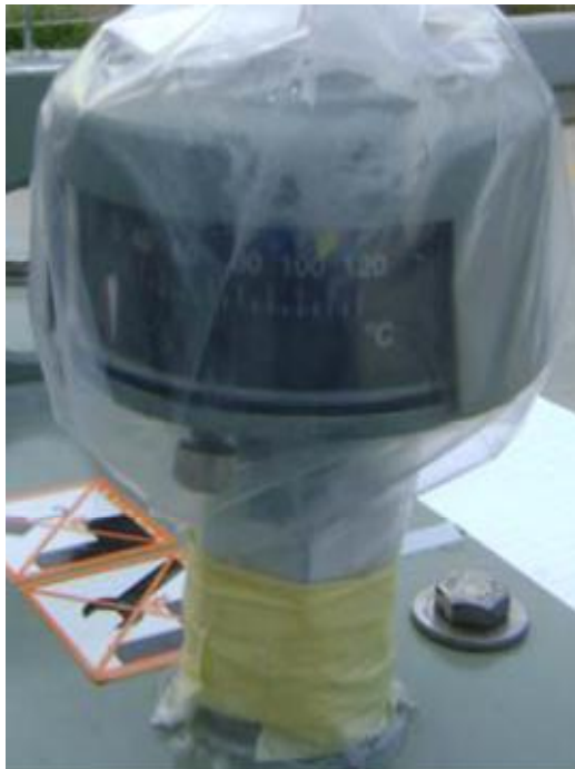
Σχ. (5.7.8): Θερμόμετρο Μ/Σ.
