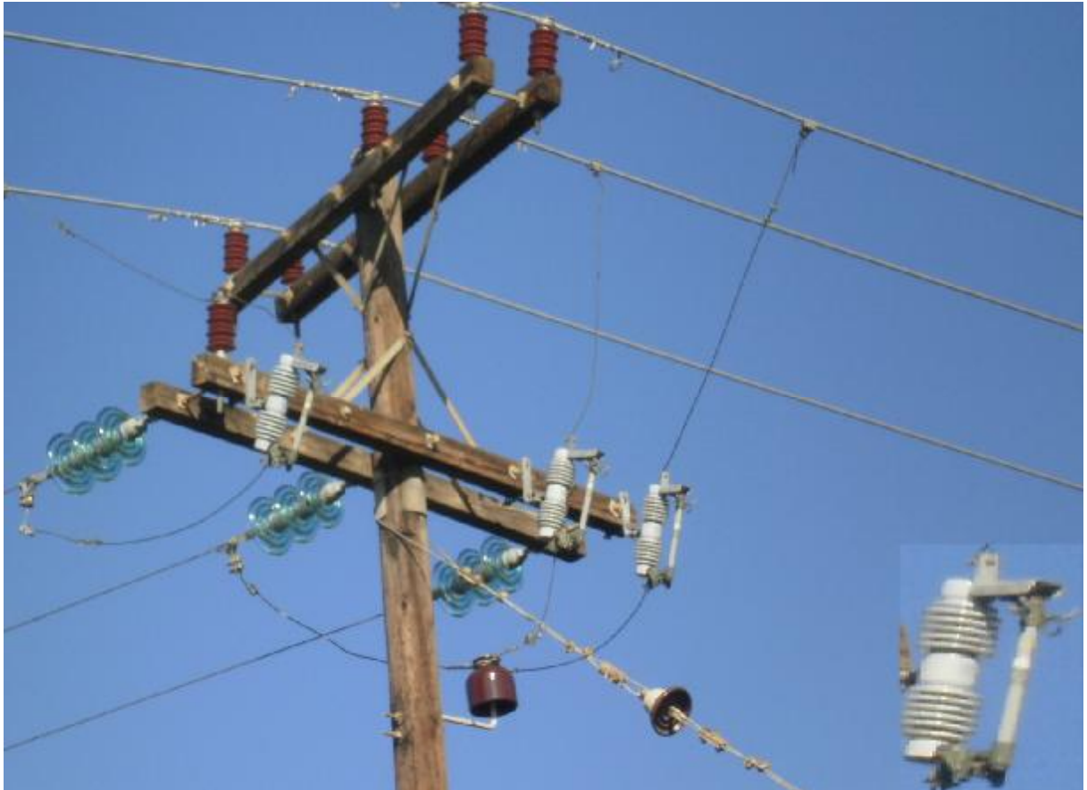
Σχ.(3.7.3): Ασφαλειοαποξεύκτες τύπου CIKAESA με κεράτια προσαρμογής
