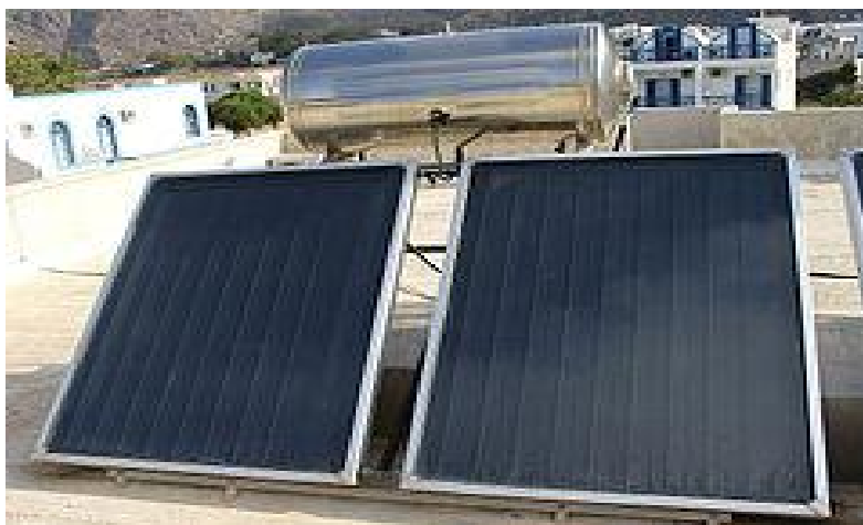
Εικ. 2.3 Χαμηλής θερμοκρασίας ηλιοθερμικό.
