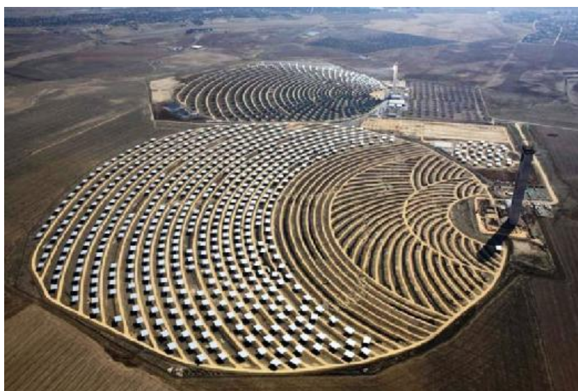
Εικ. 2.11 Ηλιοθερμικός ηλεκτροπαραγωγικός σταθμός, PS10.
