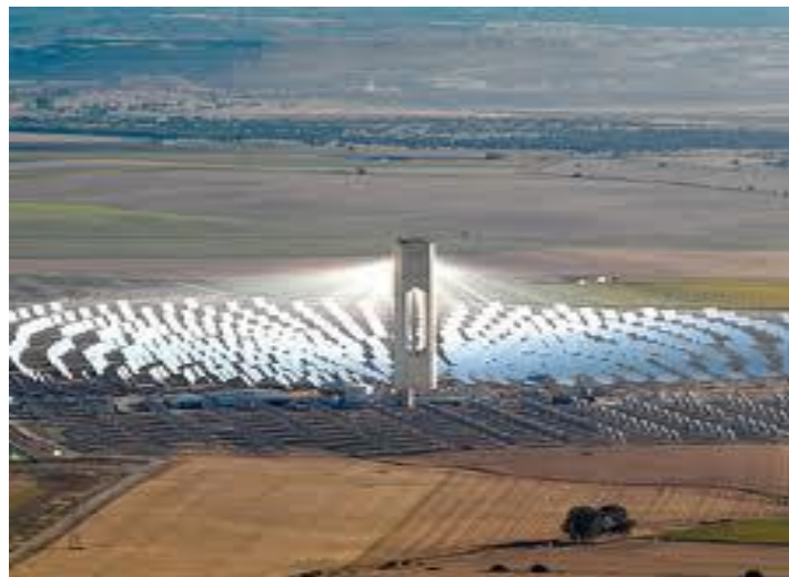
Εικ. 2.13 Ηλιοθερμικός ηλεκτροπαραγωγικός σταθμός, PS10.
