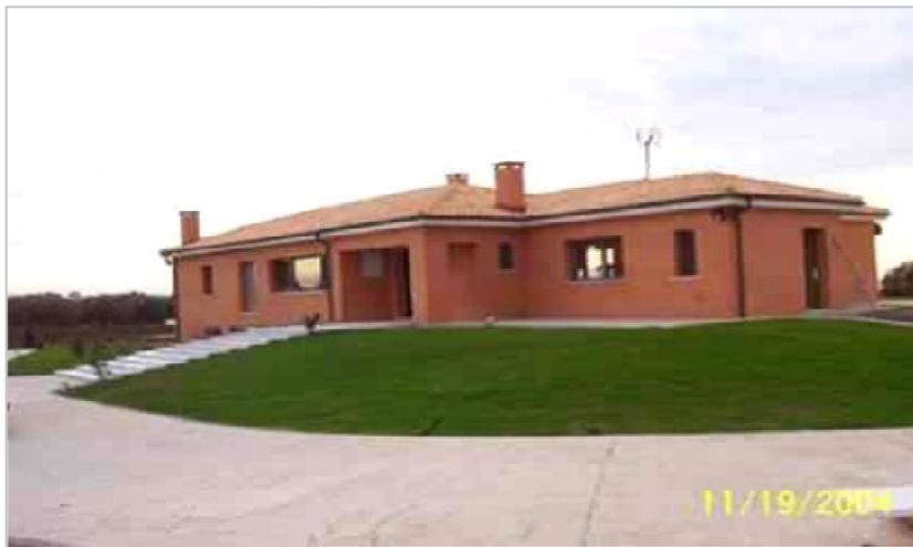
Εικ.6.6 , Ο χώρος μετά την αποκατάσταση
