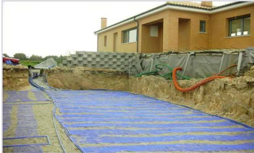
Εικ.6.5 Εγκατάσταση σωληνώσεων σε οριζόντιο σύστημα ΓΑΘ τη Θεσσαλονίκη
