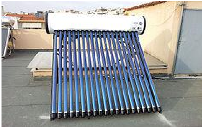
Εικ. 2.4 Χαμηλής θερμοκρασίας ηλιακός θερμοσίφοντας με σωλήνες κενού.
