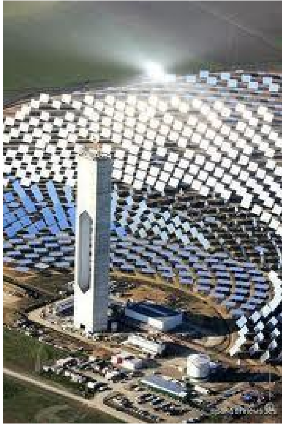
Εικ. 2.12 Ηλιοθερμικός ηλεκτροπαραγωγικός σταθμός, PS10.
