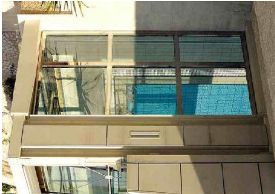
Εικόνα 7.3.: Κατασκευή αίθριου σε οροφή.
