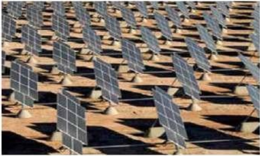
Διατάξεις ιχνηλάτησης της πορείας του ήλιου μονού άξονα
