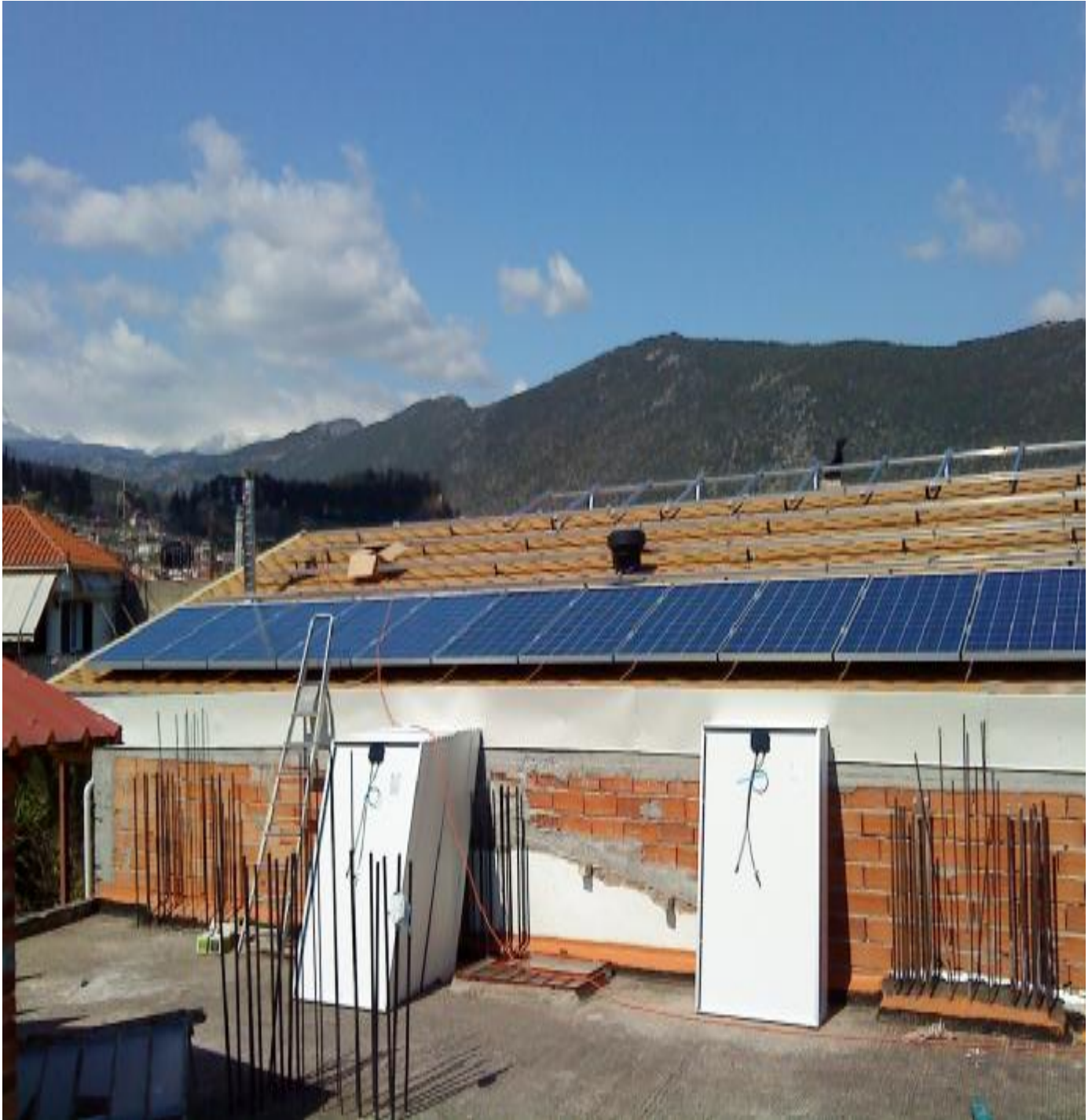
Φωτογραφία 7 : Τοποθέτηση φ/β στοιχείων
