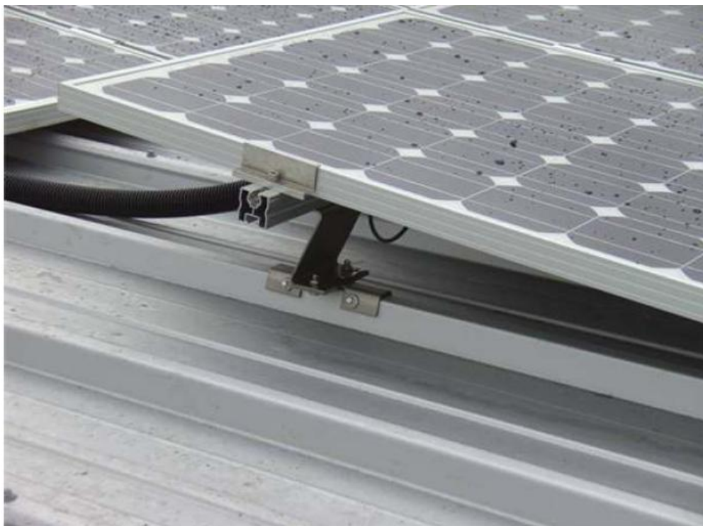
Εικόνα 1. Βάση στήριξης Πάνελ σε μεταλλική στέγη
