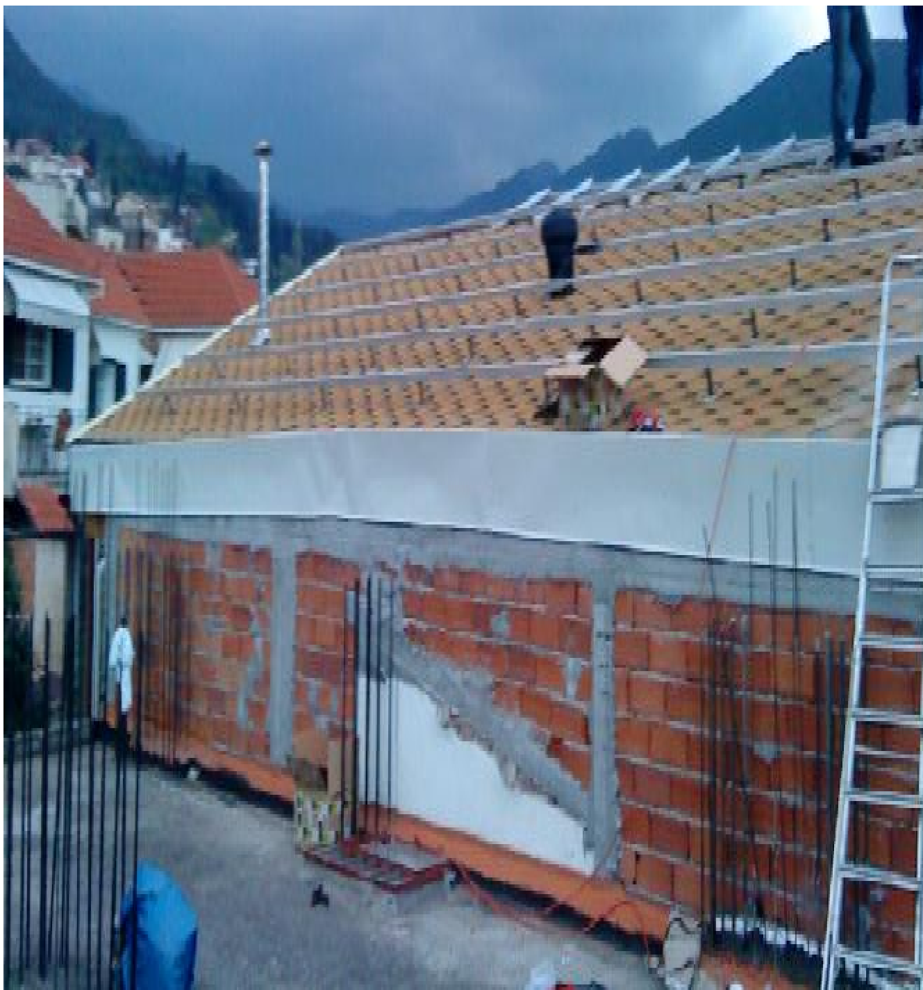
Φωτογραφία 4 Ολοκλήρωση στηρίξης οδηγών
