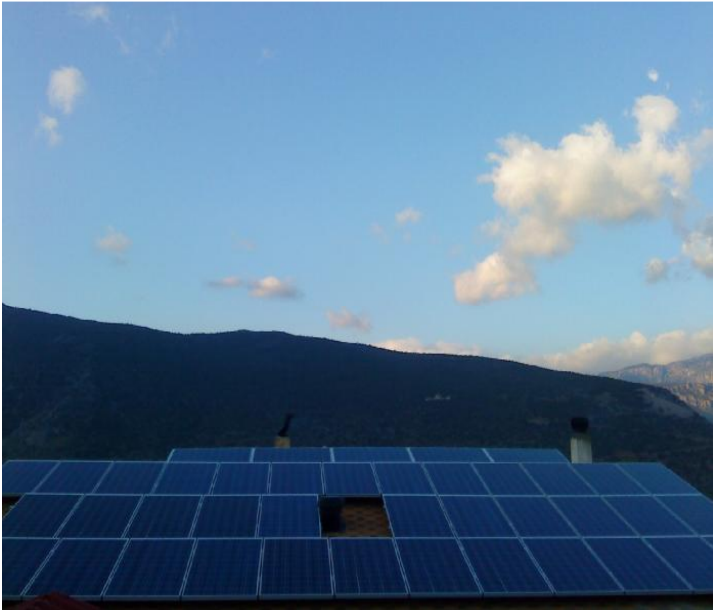
Φωτογραφία 12 : Ολοκλήρωση Χωροθέτησης και Εγκατάστασης
