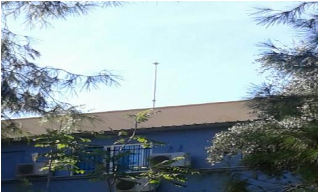
Εικόνα 3. Πίσω όψη του κτίσματος. Όπως μπορούμε να διακρίνουμε πρόκειται για το τερματικό αέρος της σειράς Dynasphere .
