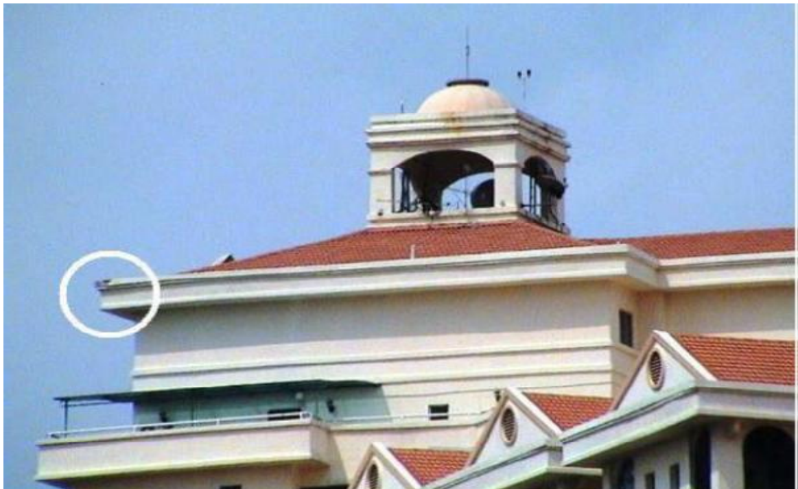
Σχήμα 23. Το σημείο πλήξης του κερανού από την νοτιοανατολική πλευρά του κτίσματος[22].
