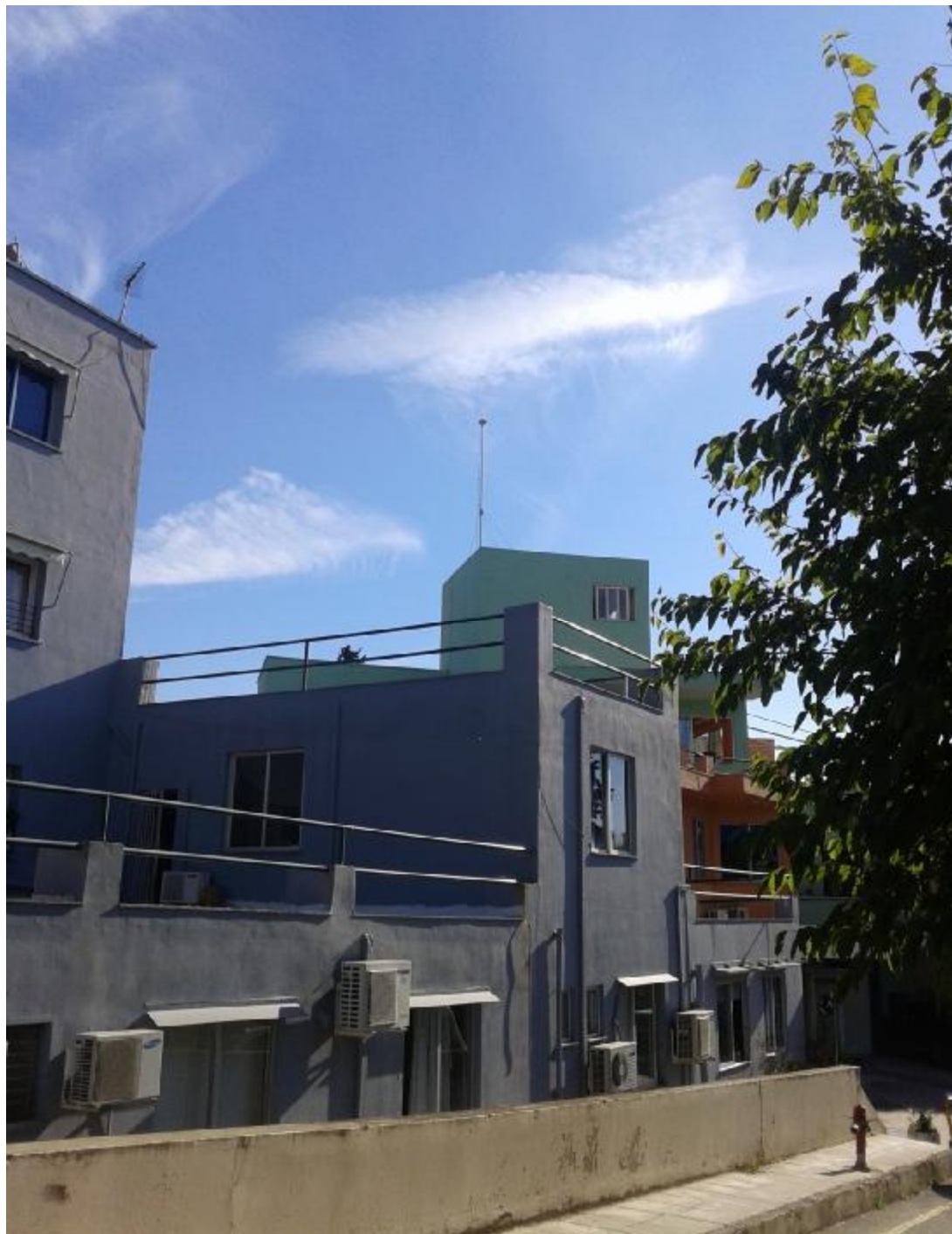
Εικόνα 1. Γενική άποψη του κτηρίου. Διακρίνεται το αλεξικέραυνο τύπου ese που το προστατεύει.
