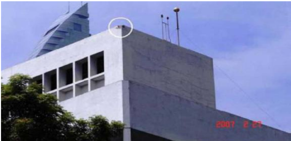
Σχήμα 19. Κοντινή φωτογραφία, εδώ φαίνεται καθαρά ότι το σημείο που χτύπησε ο κεραυνός πού είναι κοντά στο αλεξικέραυνο [22].
