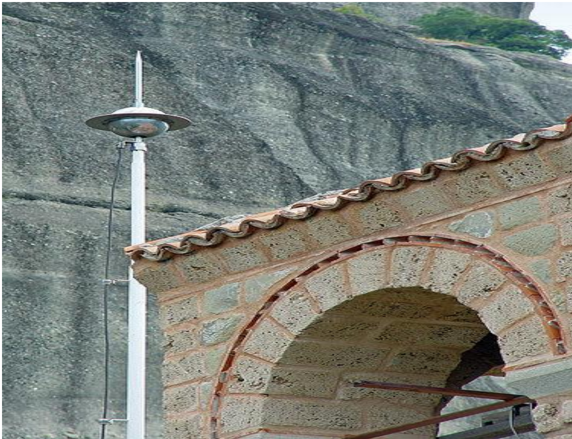
Ακίδα προστασίας ESE σειράς DYNASPHERE στο μοναστήρι του Αγ. Νικολάου στα Μετέωρα http://en.wikipedia.org/wiki/Lightning_rod
