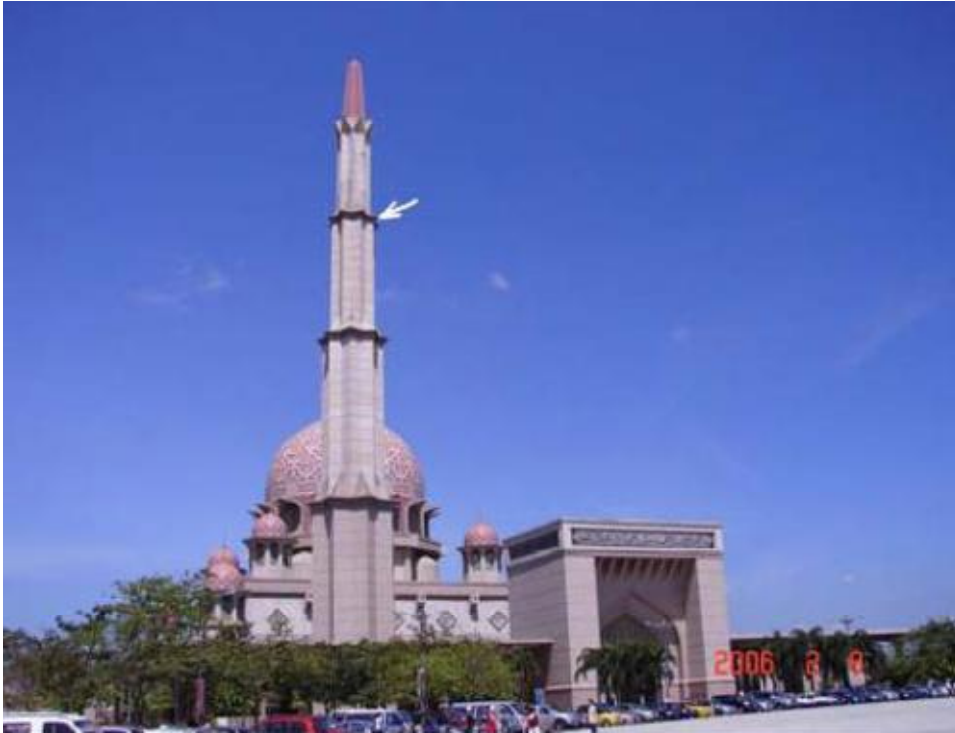
Σχήμα 25. Προστατευμένη από ese κατασκευή. Το βέλος δείχνει το σημείο που χτυπήθηκε από κεραυνό
