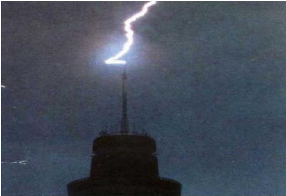
Σχήμα 28. Αλεξικέρανο τύπου ese τοποθετημένο με την CVM μέθοδο [22].
