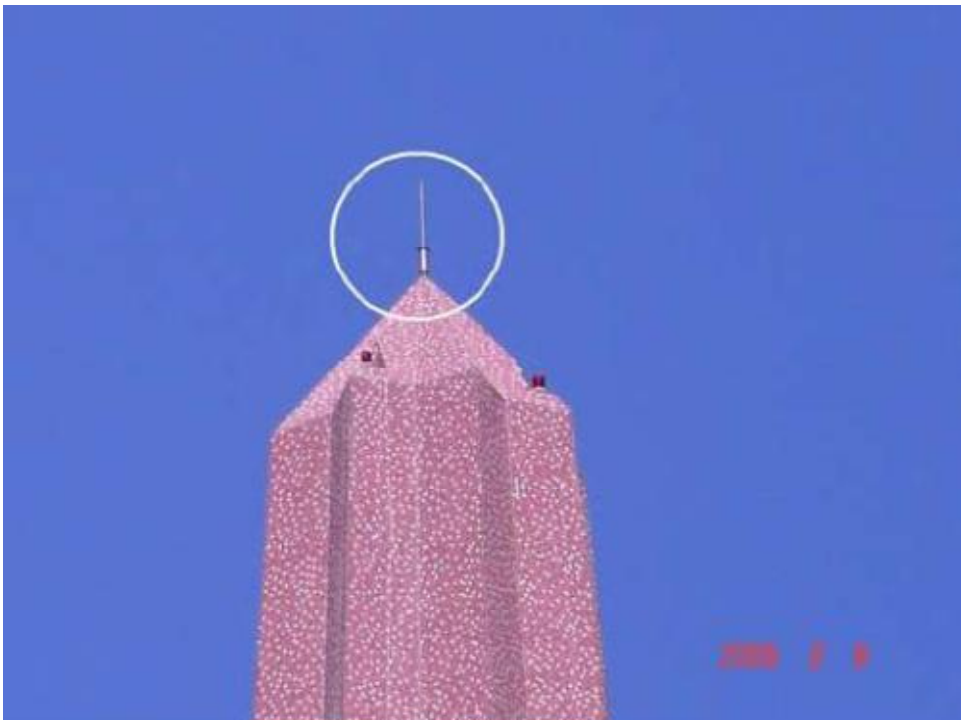
Σχήμα 26. Εδώ φαίνεται το αλεξικέρανο τύπου ese και το σημείο που ήταν τοποθετημένο [22].
