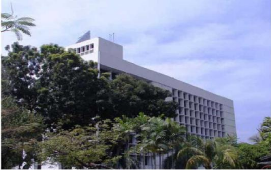
Σχήμα 18. Γενική άποψη του κτηρίου εξοπλισμένου με αλεξικέραυνο τύπου ese που είναι τοποθετημένο σύμφωνα με την μέθοδο CVM [22].
