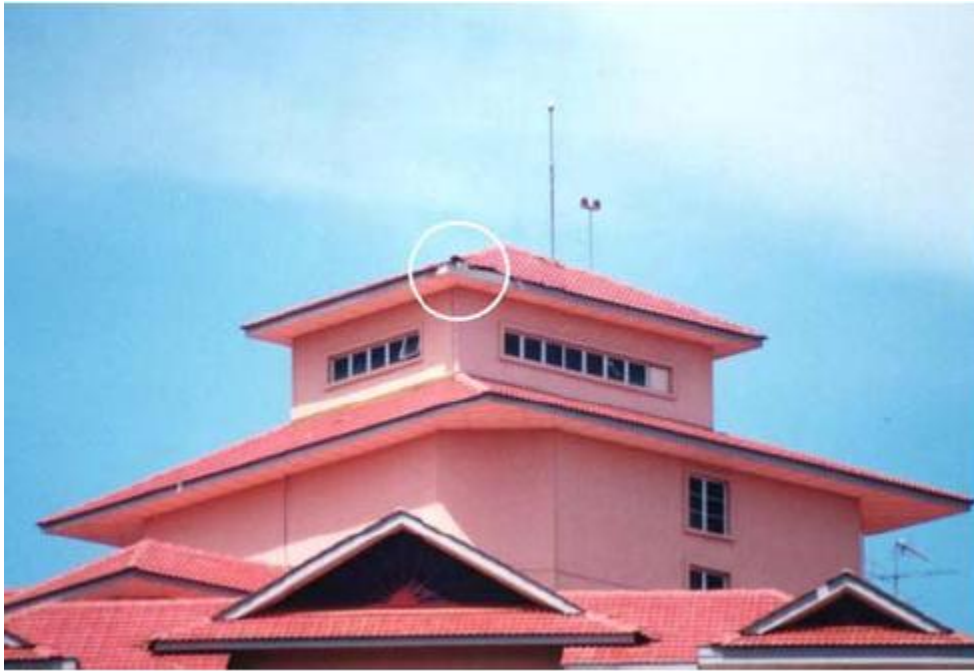
Σχήμα 17. Σημείο της κατασκευής που έπληξε ο κεραυνός, η οποία ήταν εξοπλισμένη με αλεξικέραυνο πρώιμου οχέτου κατά το πρότυπο NFC 17-102 [22].
