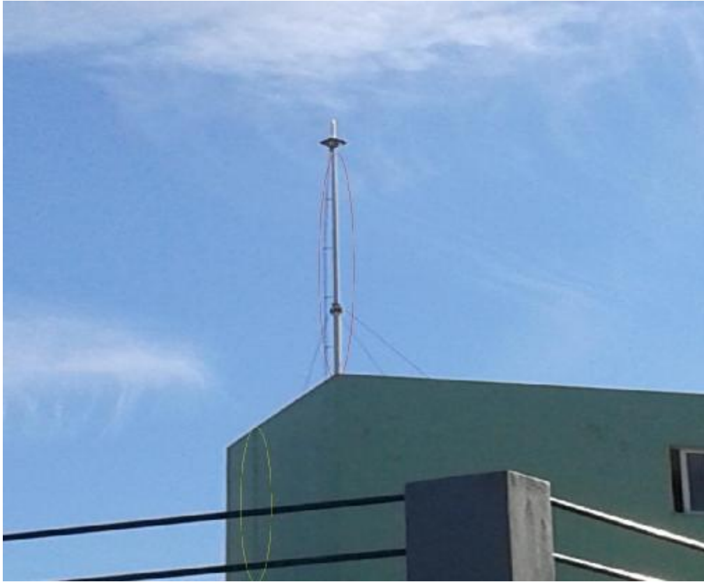
Εικόνα 2. Εστίαση στην ese ράβδο. Διακρίνεται ο ιστός που την στηρίζει και στο κάτω μέρος αχνοφαίνεται η αρχή του αγωγού καθόδου.
