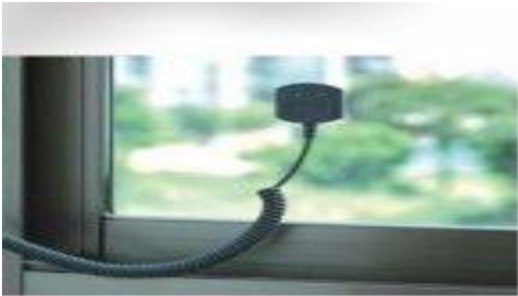
Εικόνα 20: Τοποθέτηση αισθητήρα Garrison LK-4105C στο τζάμι
