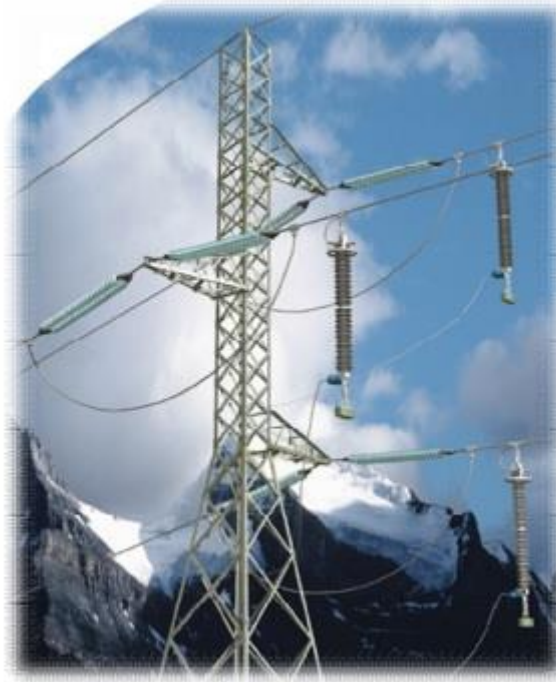
Εικόνα 18: Αλεξικέραυνα σε γραμμή μεταφοράς
