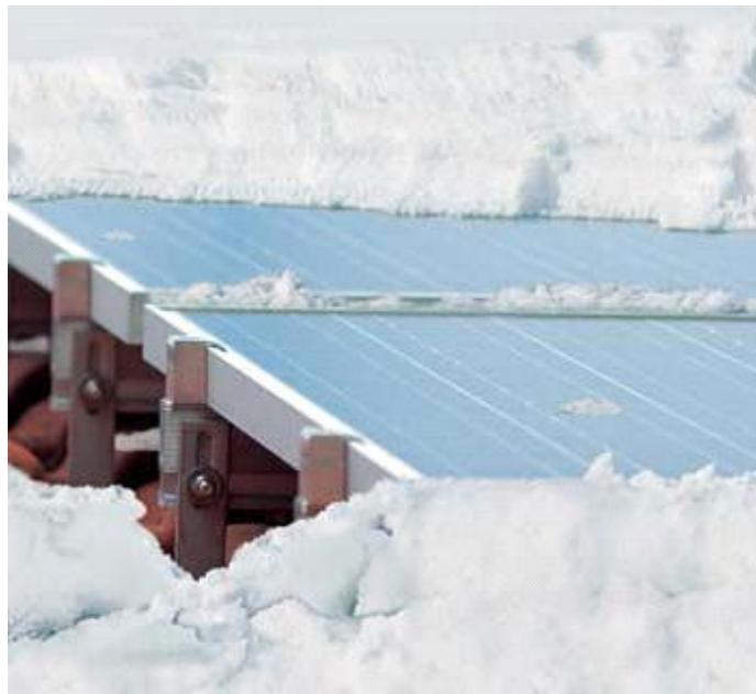
Σχήμα 4.4: Μερική κάλυψη φωτοβολταϊκού πλαισίου από χιόνι
