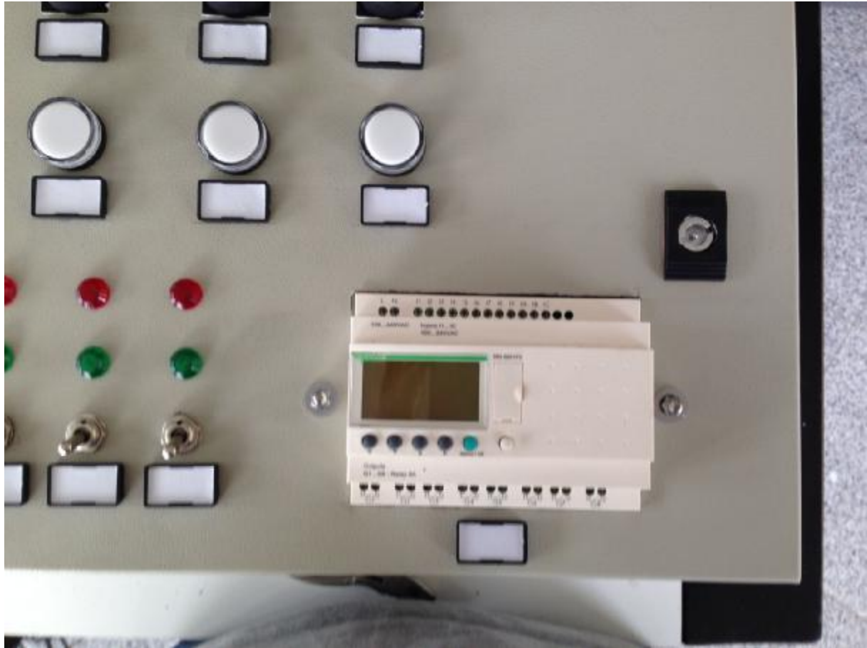
Εικ5.2.7: Τοποθέτηση του PLC.
