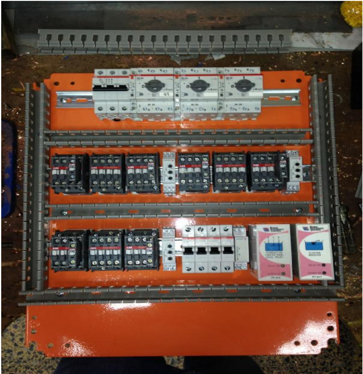
Εικ.5.2.1: Τοποθέτηση ηλεκτρονόμων, ασφαλειών, θερμομαγνητικών, επιτηρητή, φλοτέρ δεξαμενής και φλοτέρ ασφαλείας.
