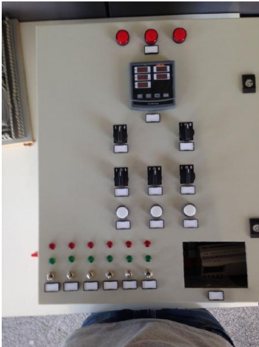
Εικ.5.2.5: Έχουν τοποθετηθεί τα διακοπτάκια για το χειρισμό και οι λυχνίες για την ένδειξη λειτουργίας.
