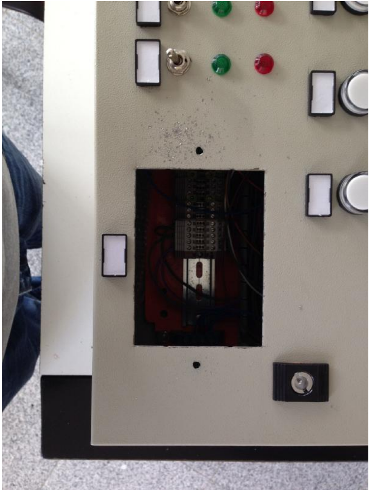
Εικ.5.2.4: Τοποθέτηση του PLC.
