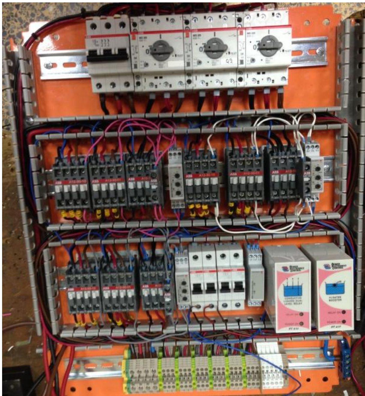
Εικ.5.2.2: Εδώ έγινε η καλωδίωση του κύριου κυκλώματος.
