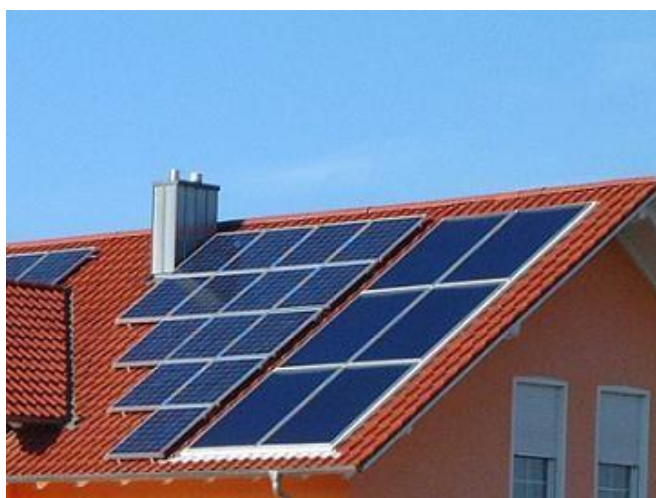
Σχήμα 1.17. Εγκατάσταση οικιακού φωτοβολταϊκού συστήματος.
