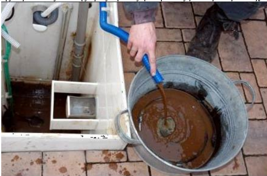
Εικόνα 5.3: Απομάκρυνση περίσσειας λάσπης
