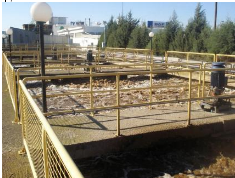
Εικόνα 5.1: Δεξαμενή αερισμού
