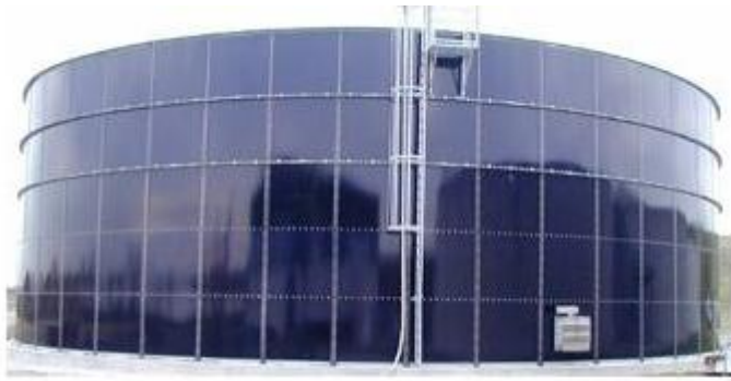
Σχήμα 4.2: Βιοαντιδραστήρας – Χωνευτήρας – Δεξαμενή Αναερόβιας Χώνευσης
