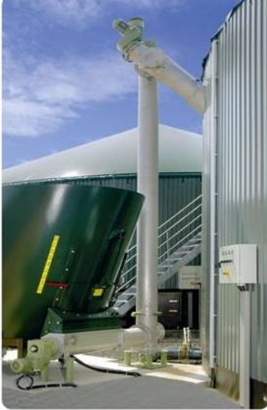
Σχήμα 4.3: Τροφοδότηση Βιομάζας με Κοχλία
