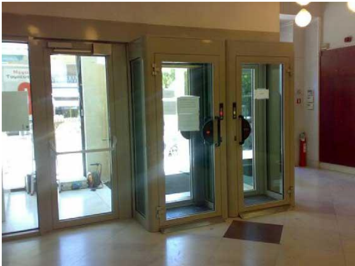
Σχήμα6.1:Θύρα αποτροπής σε τραπεζικό υποκατάστημα
