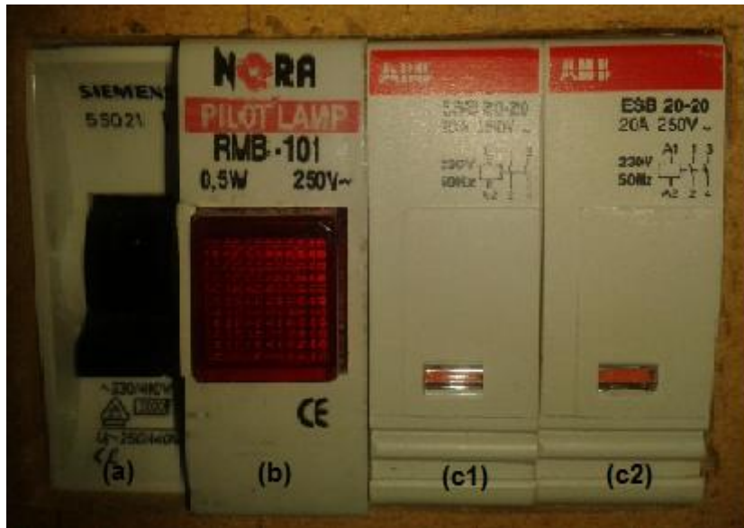
Σχήμα 2.7: Διακόπτης (a), Ενδεικτική λυχνία (b), Ρελέ (c1, c2)
