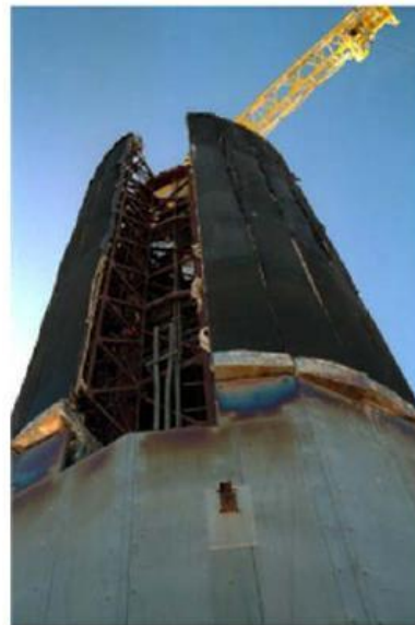
Σχήμα 28 Παράδειγμα Εξωτερικού Κυλινδρικού Ηλιακού Δέκτη της Εγκατάστασης Πύργου Ηλιακής Ισχύος [20]
