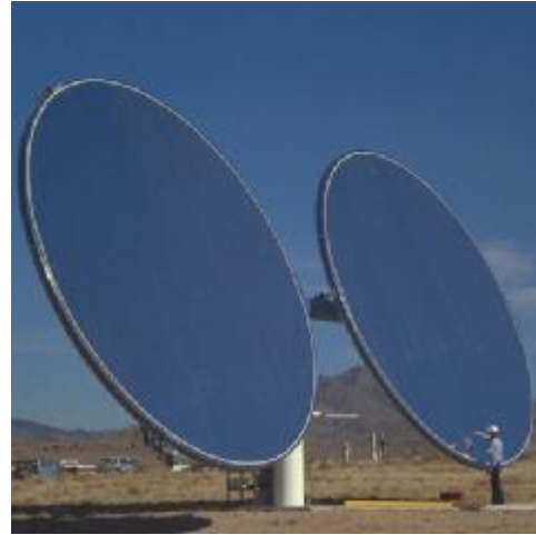
Σχήμα 24 Τυπικός Ηλιοστάτης και Ηλιοστάτης Τεντωμένης Μεμβράνης αντίστοιχα [21],[22]
