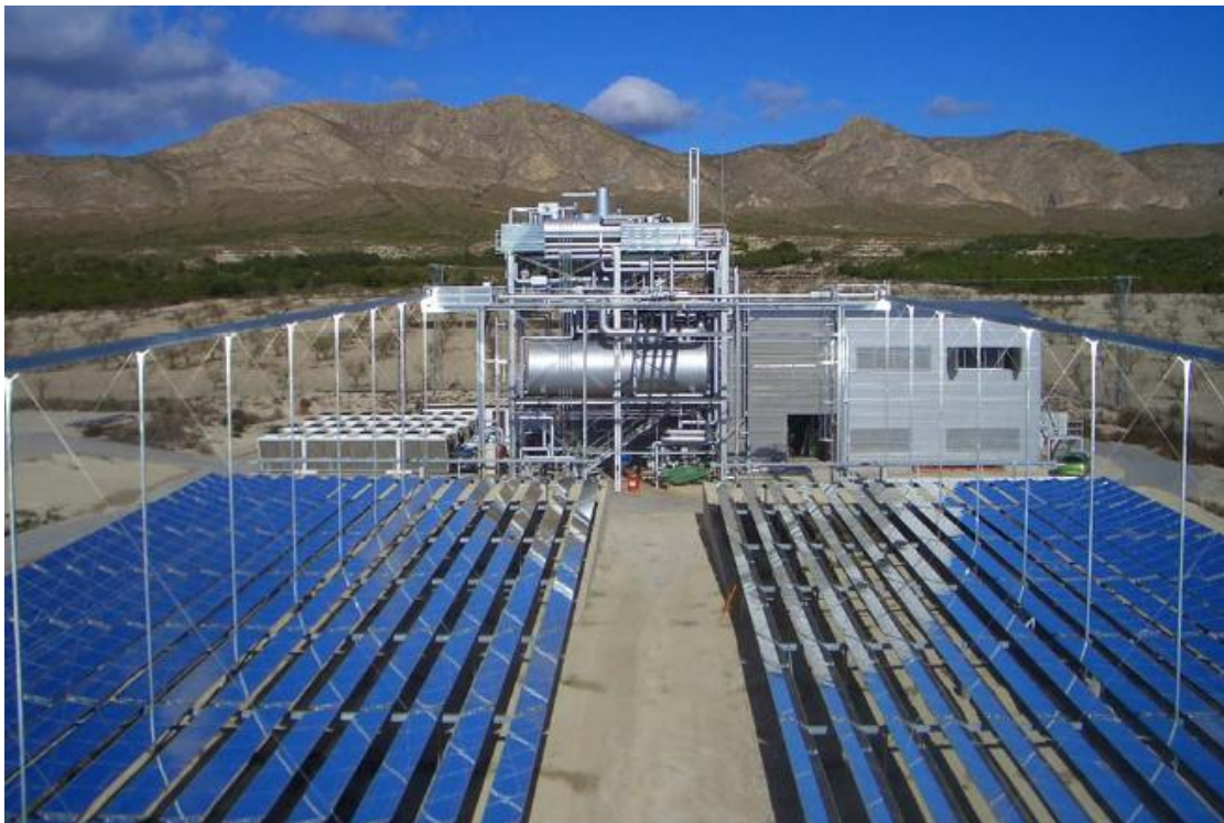
Σχήμα 8 Τοπικό Σύστημα με Γραμμικούς Ανακλαστήρες τύπου Fresnel [8]
