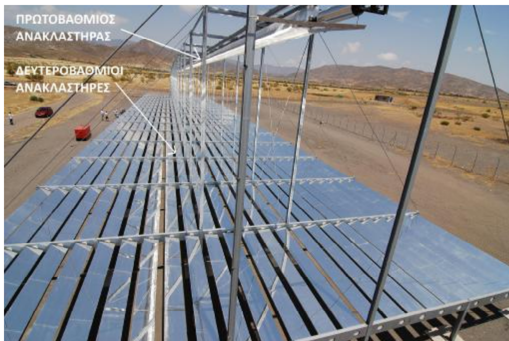
Σχήμα 53 Αρχή λειτουργίας του συλλέκτη Fresnel [47]
