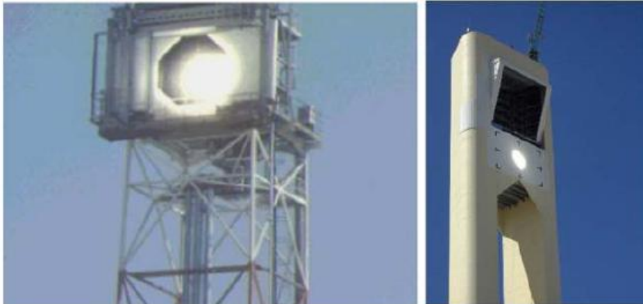
Σχήμα 29 Παράδειγμα Ηλιακού Δέκτη Κοιλότητας [20]
