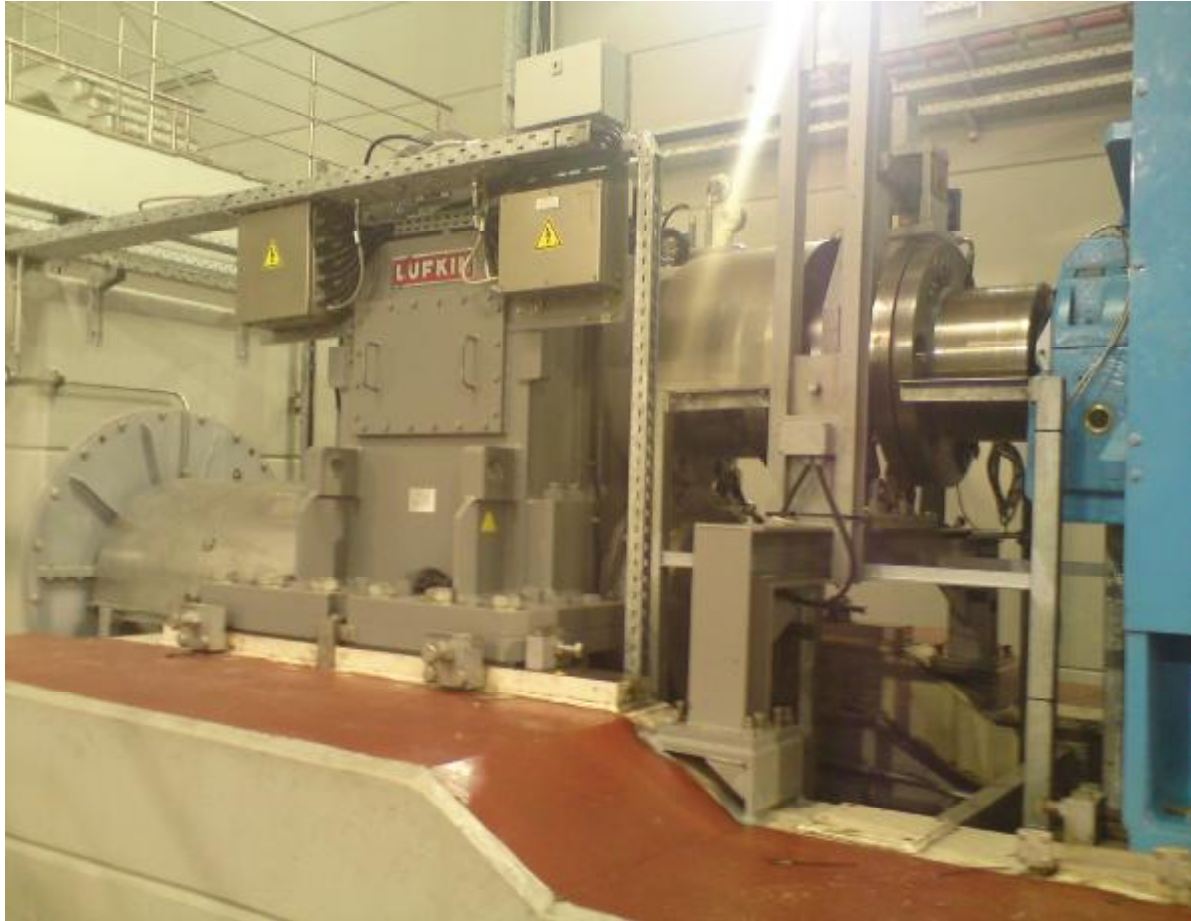
Ο πολλαπλασιαστής ταχύτητας(σασμάν) του σταθμού παραγωγής
