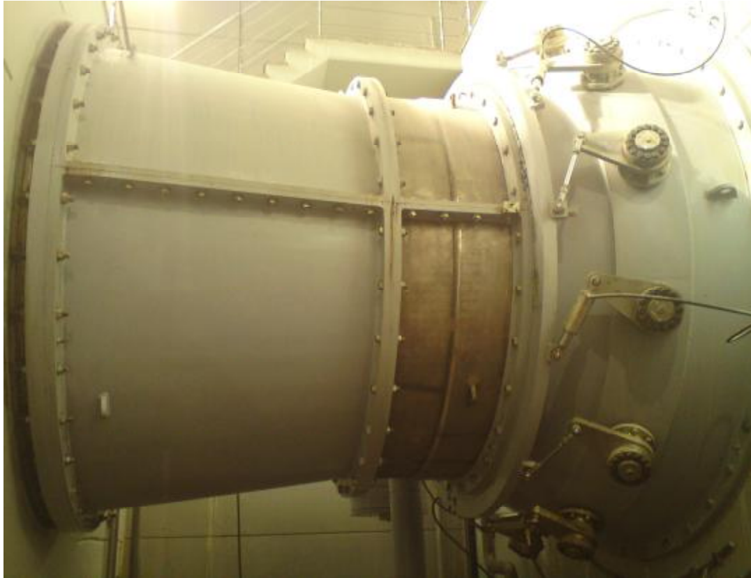
Εντός του σωλήνα βρίσκεται ο υδροστρόβιλος και τα οδηγιά πτερύγια
