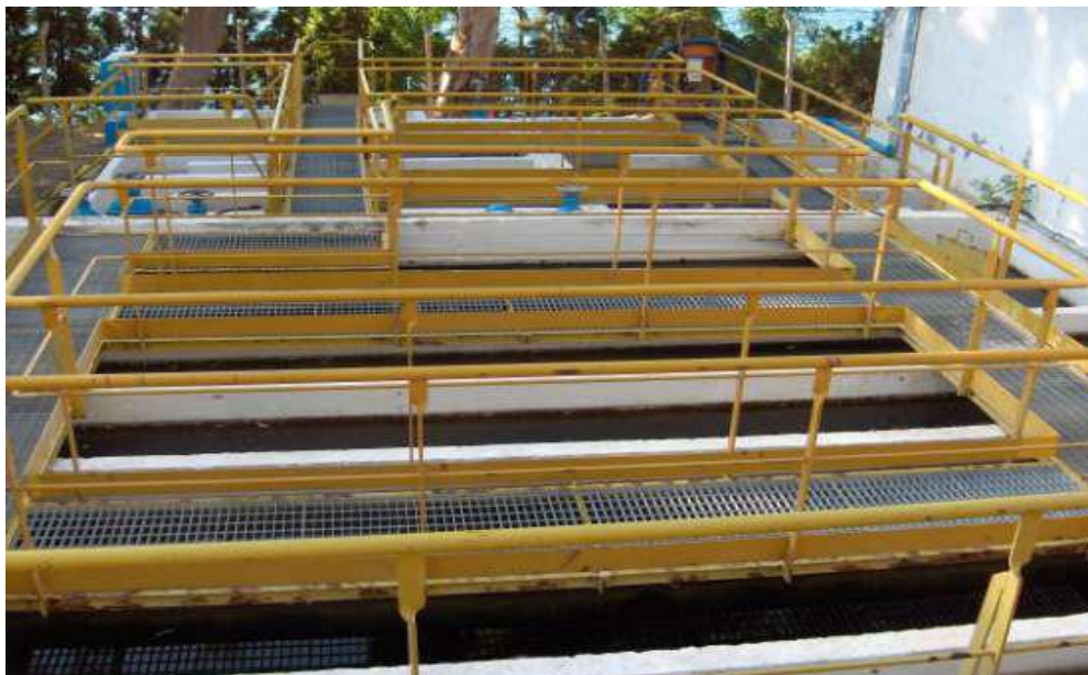
Εικόνα 1.5.9: Στάδιο χλωρίωσης
