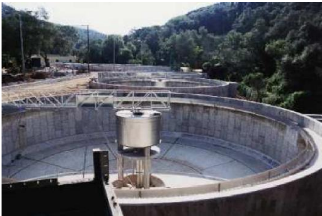
Εικόνα 1.5.6: Δεξαμενή καθίζησης
