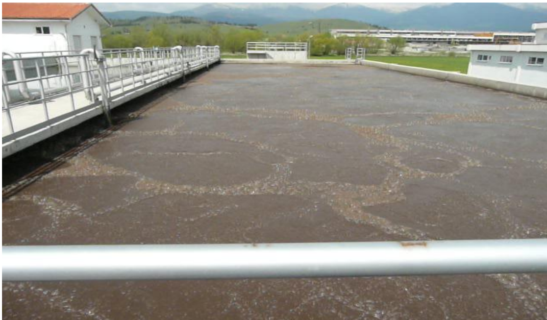
Εικόνα 1.5.5: Δεξαμενή αερισμού
