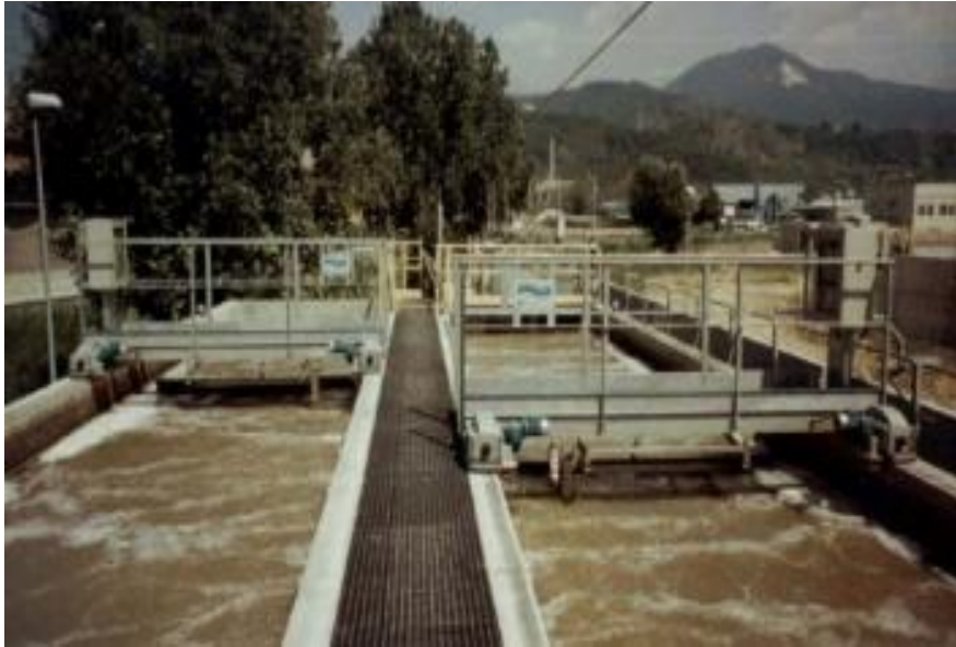
Εικόνα 2.2.2: Εξάμμωση-Λιποσυλλογή
