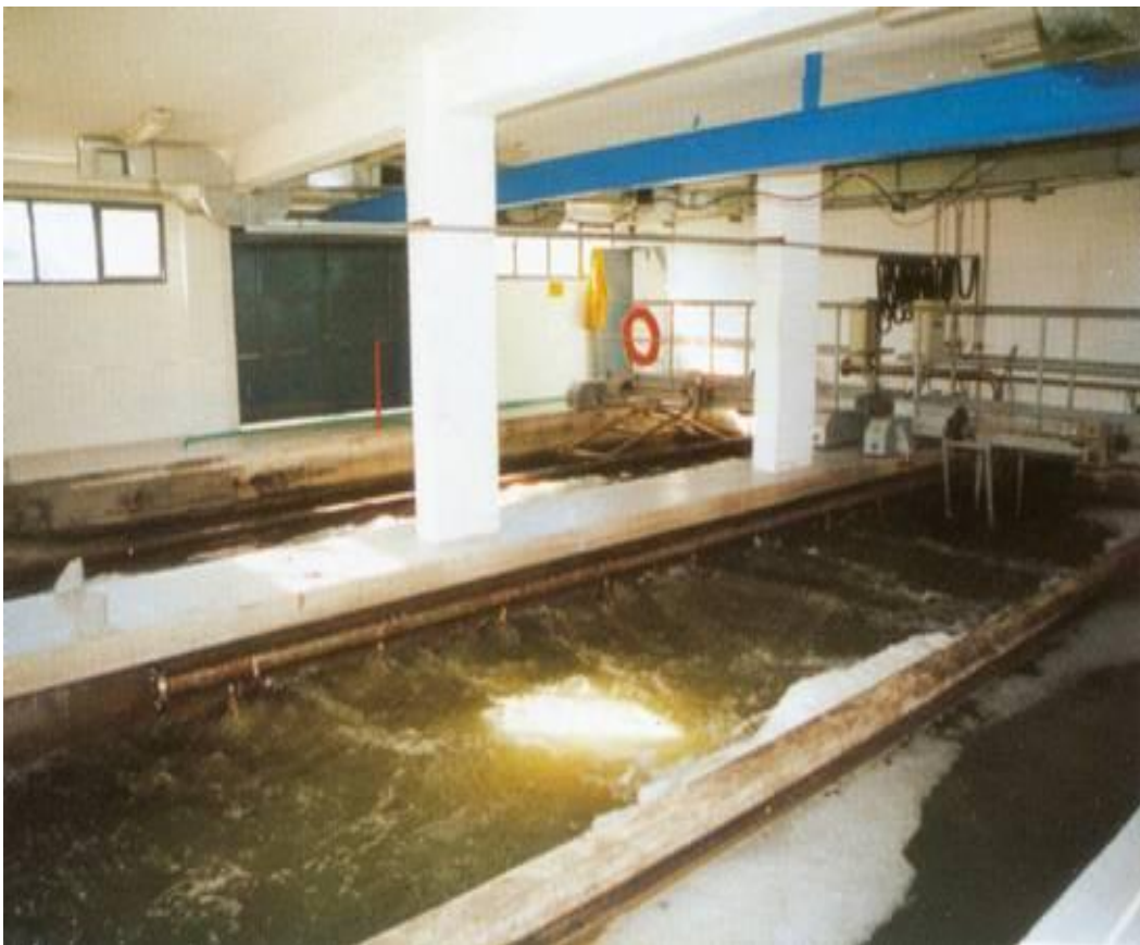
Εικόνα 1.5.2: Φρεάτιο αναρρόθμισης
