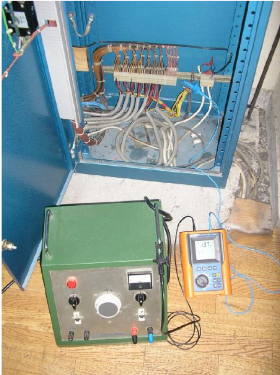
Εικόνα 6.2 Μέτρηση ελέγχου συνέχειας αγωγού
