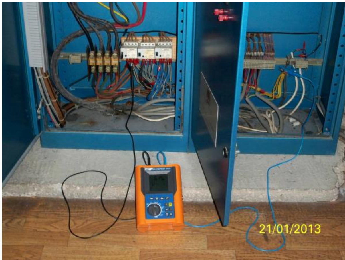
Εικόνα 6.3 Μέτρηση της αντίστασης μόνωσης
