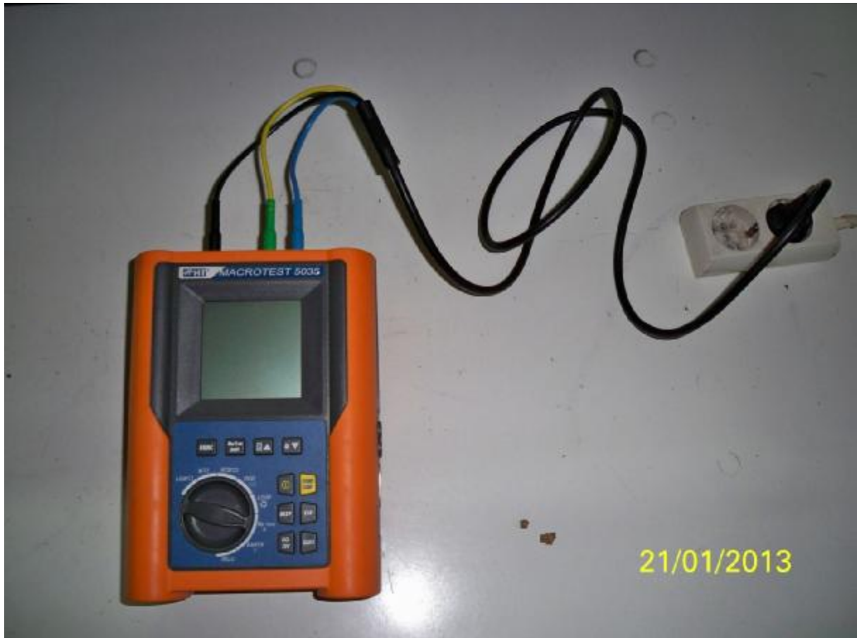
Εικόνα 6.7 μέτρηση σύνθετης αντίστασης βρόχου σφάλματος και ρεύματος βραχυκυκλώματος για P-N
