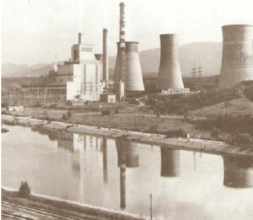
Σχήμα 1.1 Λιγνιτοθερμικός σταθμός Πτολεμαΐδας [5]
