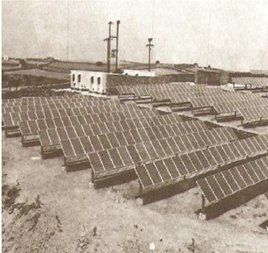
Σχήμα 1.3 Φωτοβολταϊκός σταθμός Κύθνου [5]
