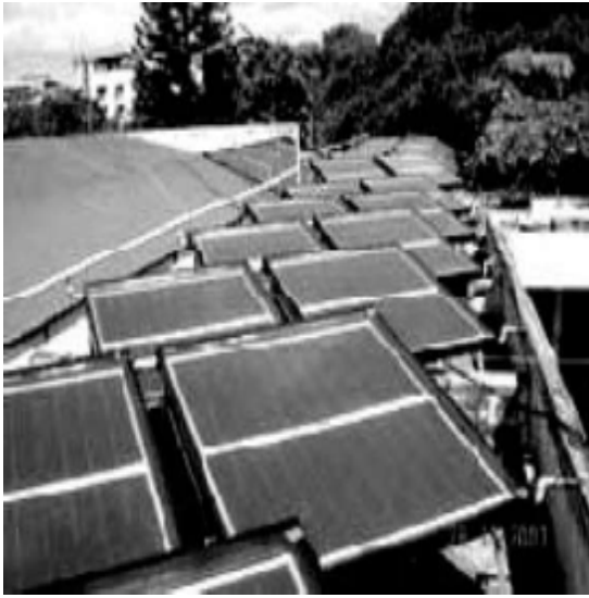
Εικόνα(45). Εγκαταστάσεις PV/T TFPV στην Ταϊλάνδη.
