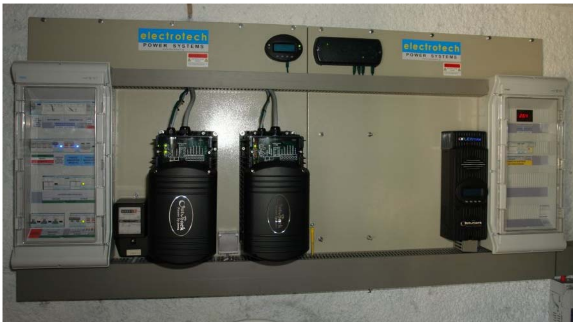
Εικ.9 Σύστημα Φ/Β εγκατάστασης
