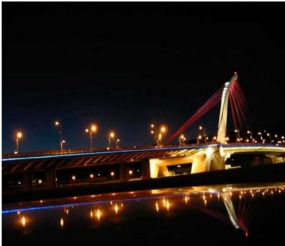
Εικόνα 4-3: Φωτισμός γέφυρας με φωτιστικά Led
