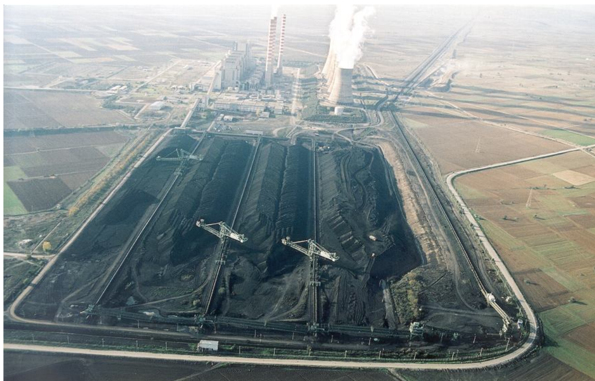
Σχήμα 7. Διακρίνονται : Αυλή λιγνίτη, ταινιόδρομοι, απολήπτες - αποθέτες
