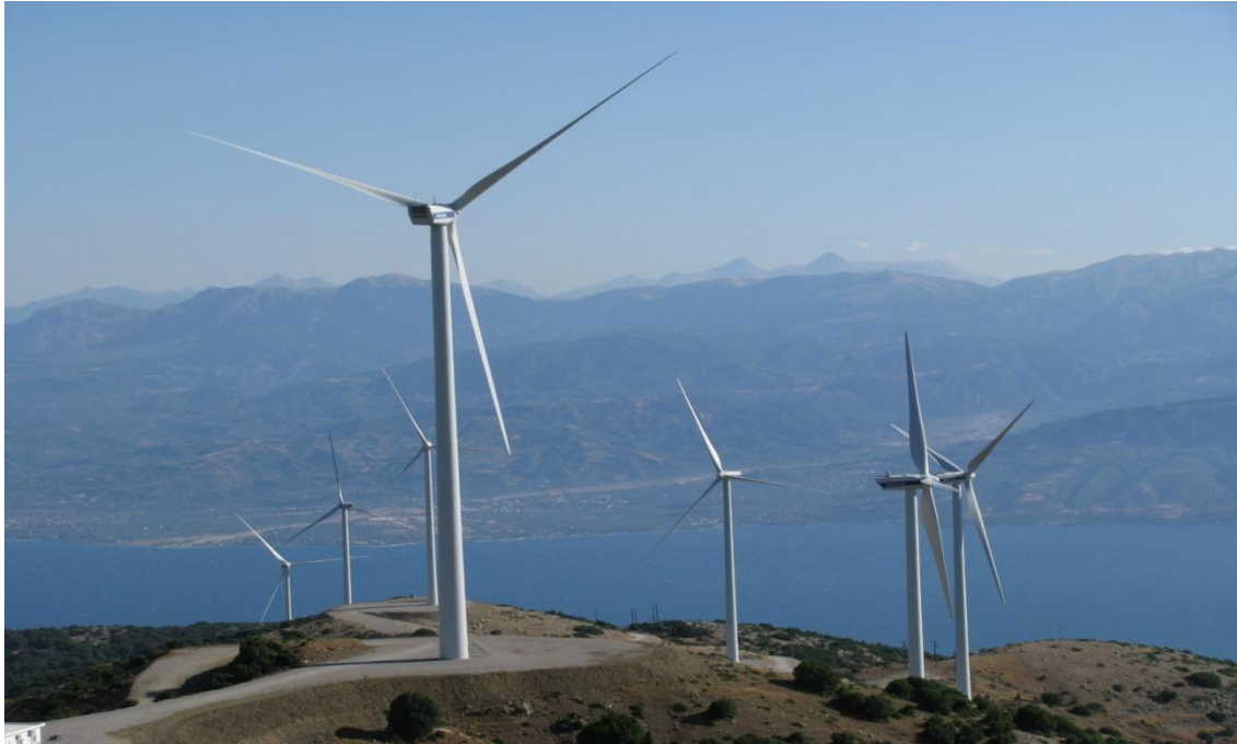
Εικόνα 93: Η ομαλότητα του λόφου πάνω από το χωριό πρόσφερε ευκολία στην κατασκευή των δρόμων προσέγγισης των ανεμογεννητριών
