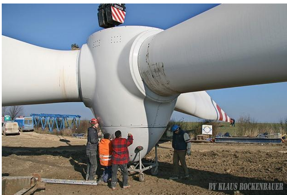
Εικόνα 70: Ρότορας ανεμογεννήτριας V90 κατά τη διάρκεια συναρμολόγησης
