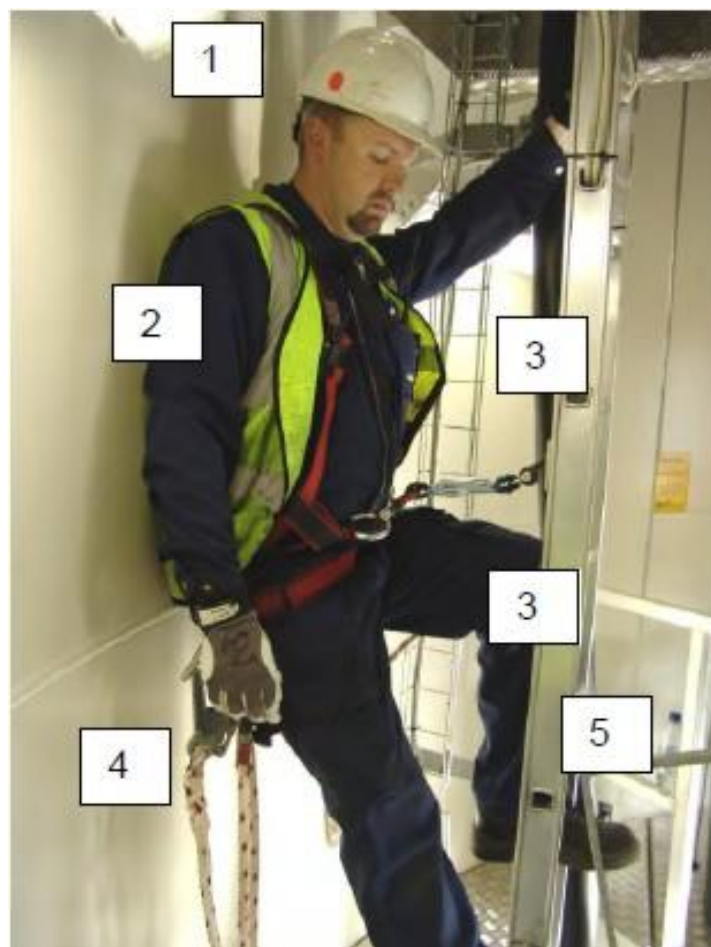
Εικόνα 47: Μηχανικός συντήρησης κατά την άνοδο του στον πύργο μιας ανεμογεννήτριας V90
