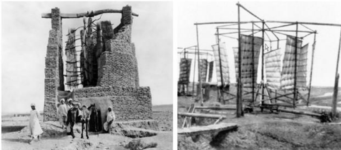
Εικόνα 17 : Ανεμόμυλοι της Αρχαίας Περσίας για άλεση δημητριακών (αριστερά) και της Αρχαίας Κίνας για άντληση νερού
