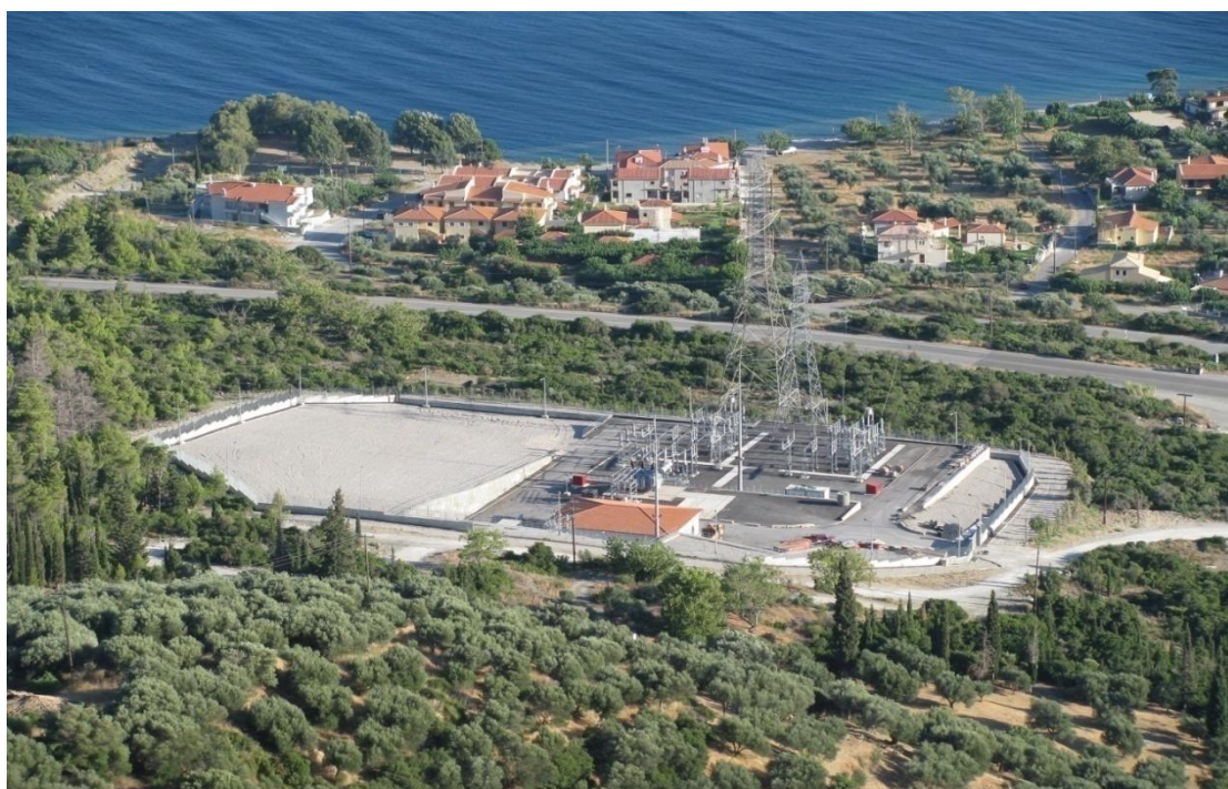
Εικόνα 88 : Η Εθνική οδός Αντιρρίου – Ιτέας, πυλώνες ΔΕΗ και ο σταθμός διασύνδεσης όπως φαίνονται από το πάρκο
