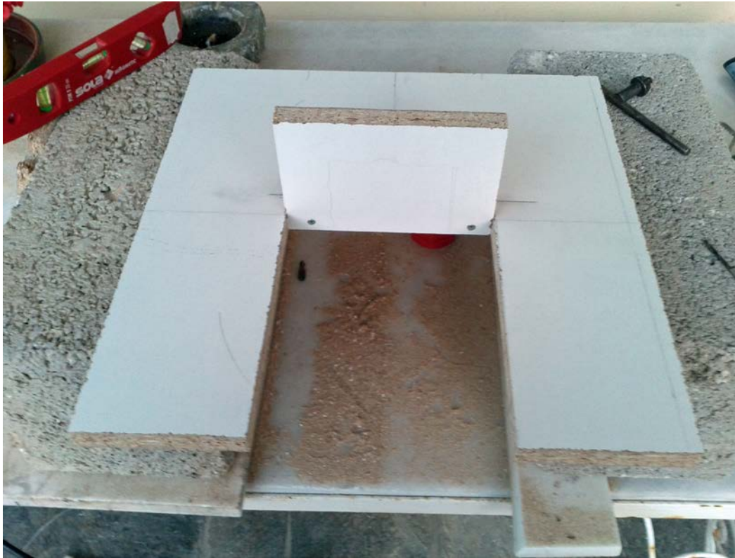
Εικόνα 7.5: Τοποθέτηση Κάθετης Επιφάνειας στο Ξύλο (Οψη)
