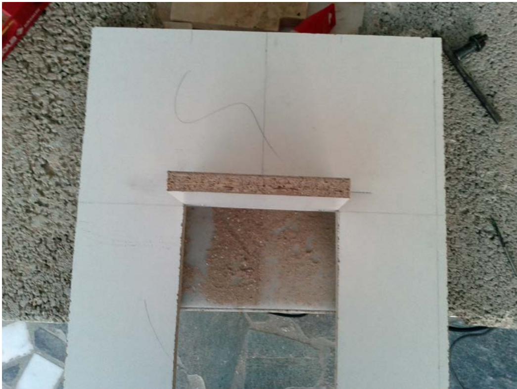
Εικόνα 7.6 : Τοποθέτηση Κάθετης Επιφάνειας στο Ξύλο (Κάτοψη)
