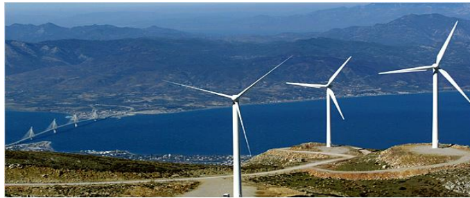
Εικόνα 1.10: Αιολικό πάρκο στην Πάτρα
