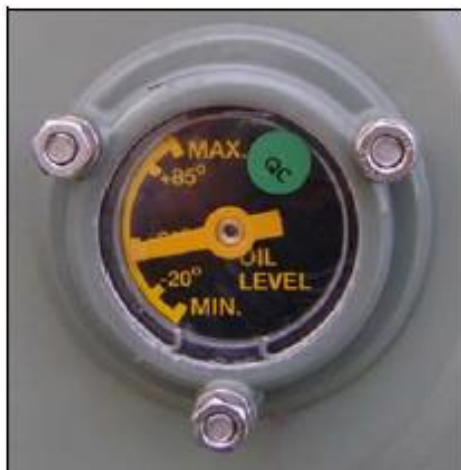
Σχήμα 7.7.3 Δείκτης στάθμης λαδιού στο δοχείο διαστολής
