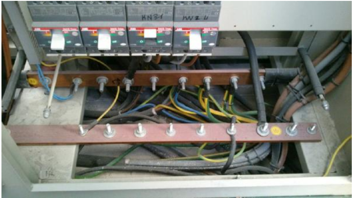
Οι οδεύσεις των καλωδίων στο χαντάκι κάτω από το πεδίο χαμηλής τάσης του πελάτη.
