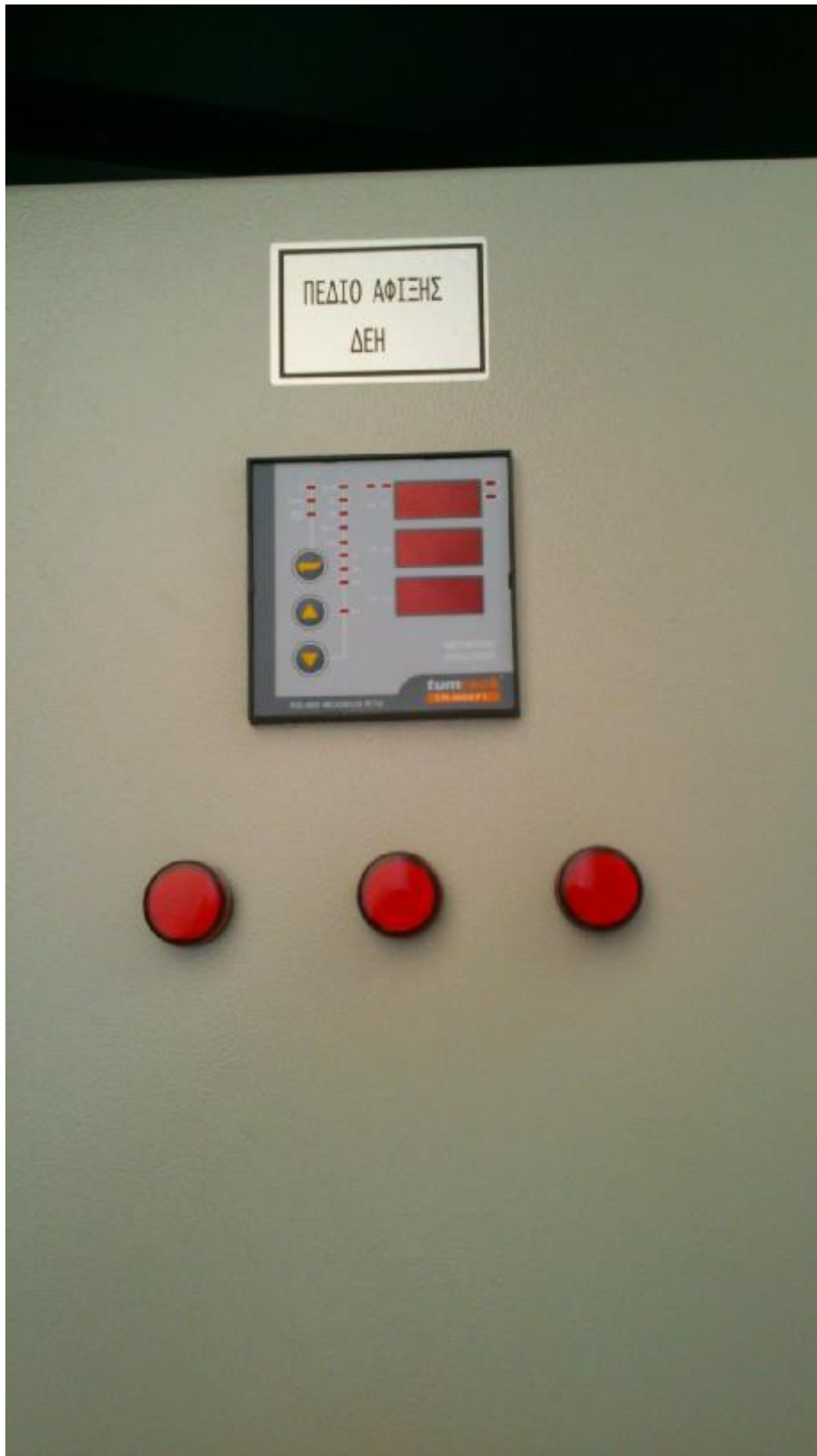
Η εμπρόσθια όψη του αναλυτή και τα ενδεικτικά τάσεως των 3 ου φάσεων L1,L2,L3
