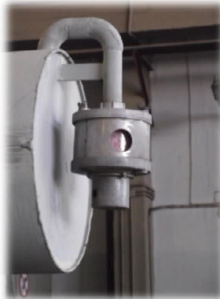
Σχήμα 7.7.4 Αφυγραντήρας με Silica Gel
