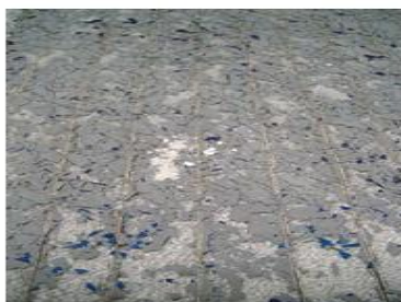
εικόνα panel μετά την θερμική διαδικασία
