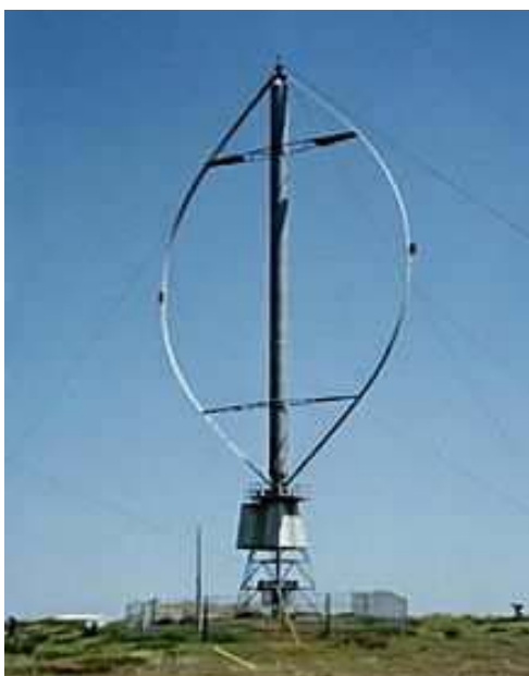
Σχήμα 1.8 Ανεμογεννήτρια τύπου Darrieus.
