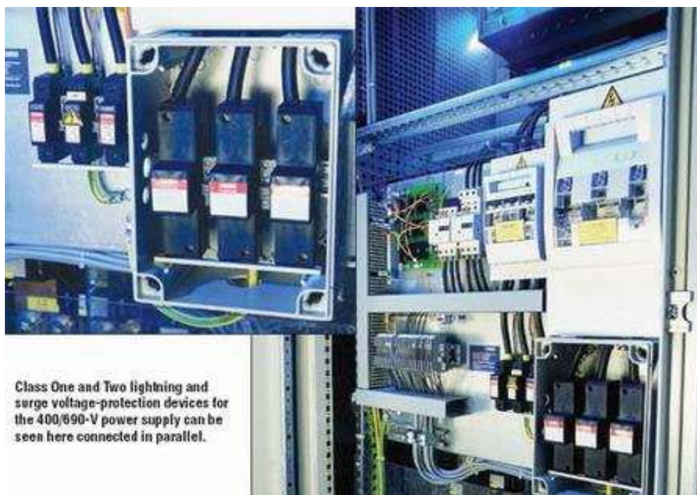
Σχήμα 1.4 Εκτροπείς υπερτάσεων σε μεγάλες ανεμογεννήτριες.
