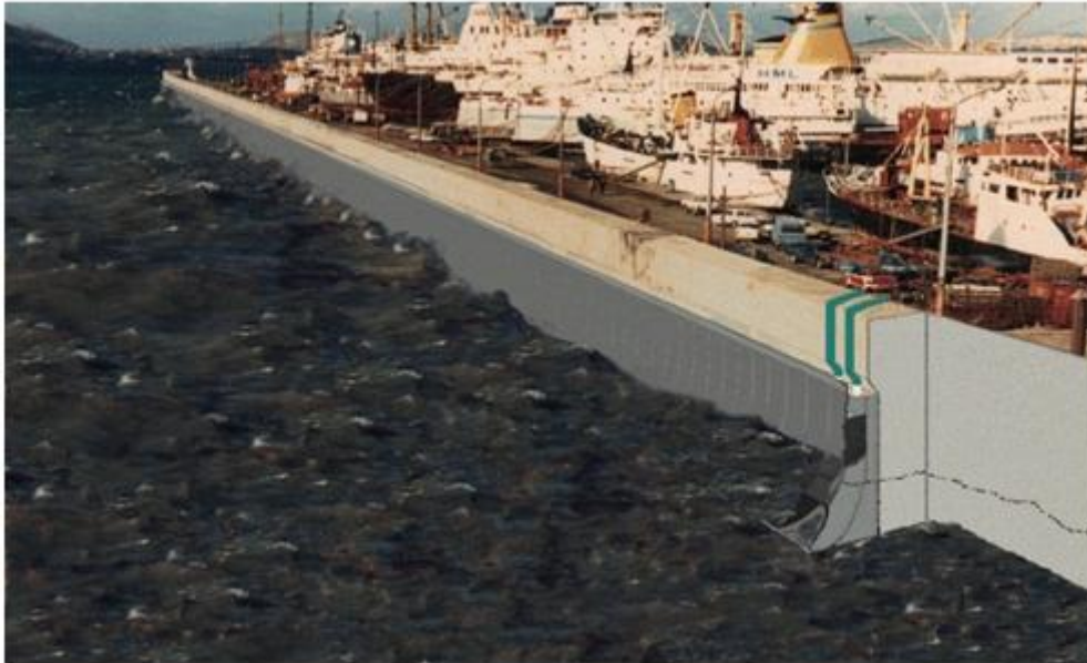
Εικόνα11: Η προτεινόμενη κυματοθραυστική εφαρμογή WECA
