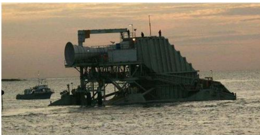
Εικόνα21: Η πλήρης εγκατάσταση Oceanlinx
