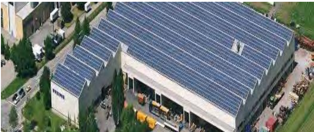
Ενσωμάτωση φωτοβολταϊκών σε βιομηχανική στέγη
