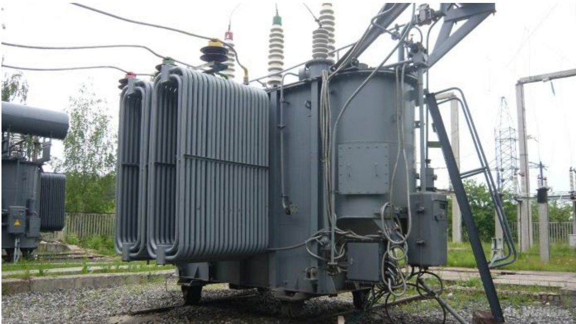
Σχήμα 1.5 Μετασχηματιστής 150kV/20kV
