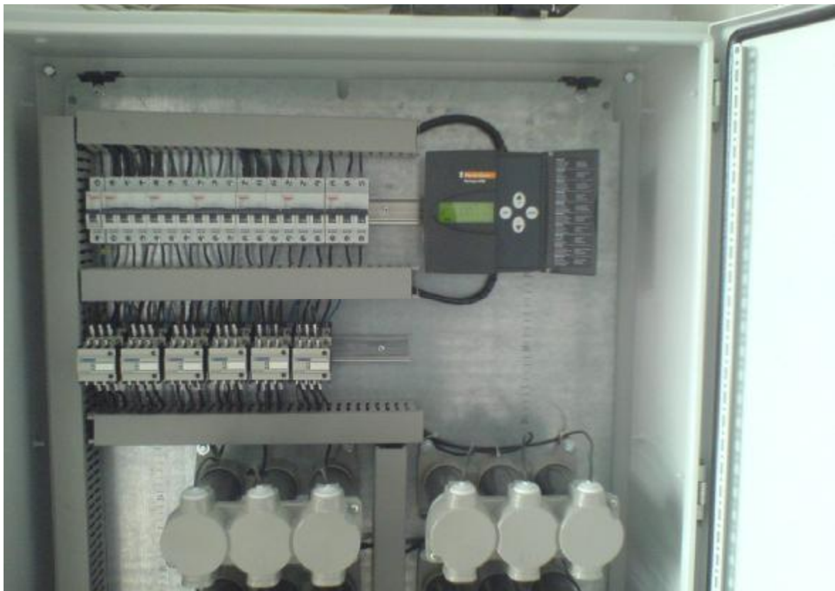
Εικόνα 3 Παράδειγμα Πίνακα Αντιστάθμισης
