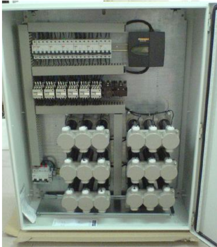
Εικόνα 4: Ο πίνακας Αντιστάθμισης με όλες τις συστοιχίες των πυκνωτών
