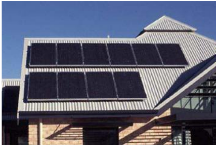
Εικ.iv.8. Πρώτη γενιά BIPV
