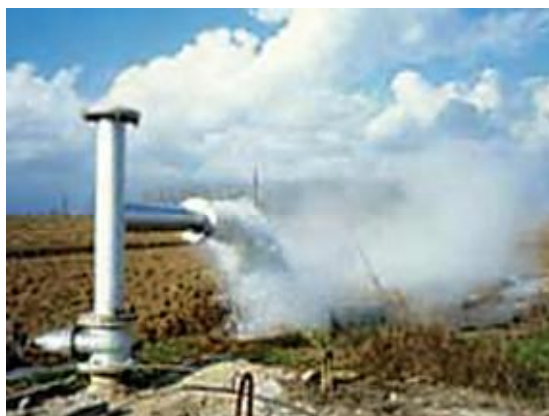
Σχήμα 1.3: Γεωθερμική γεώτρηση στη Ν.Κεσσάνη (Ν. Ξάνθης)
