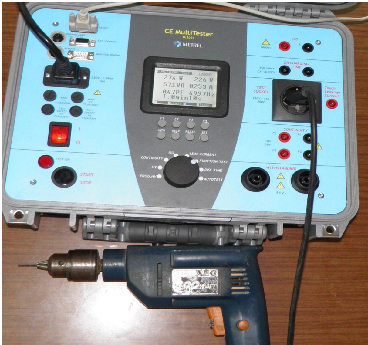
Εικ. 5.4.1 Δοκιμή λειτουργίας ηλεκτρικό τρυπάνι Functional Test 10sec
