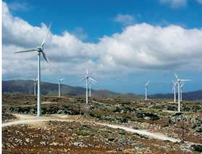
Σχήμα 1.4: Αιολικό πάρκο στην περιοχή Αχλάδια Σητείας Κρήτης, ισχύος 27,5MW
