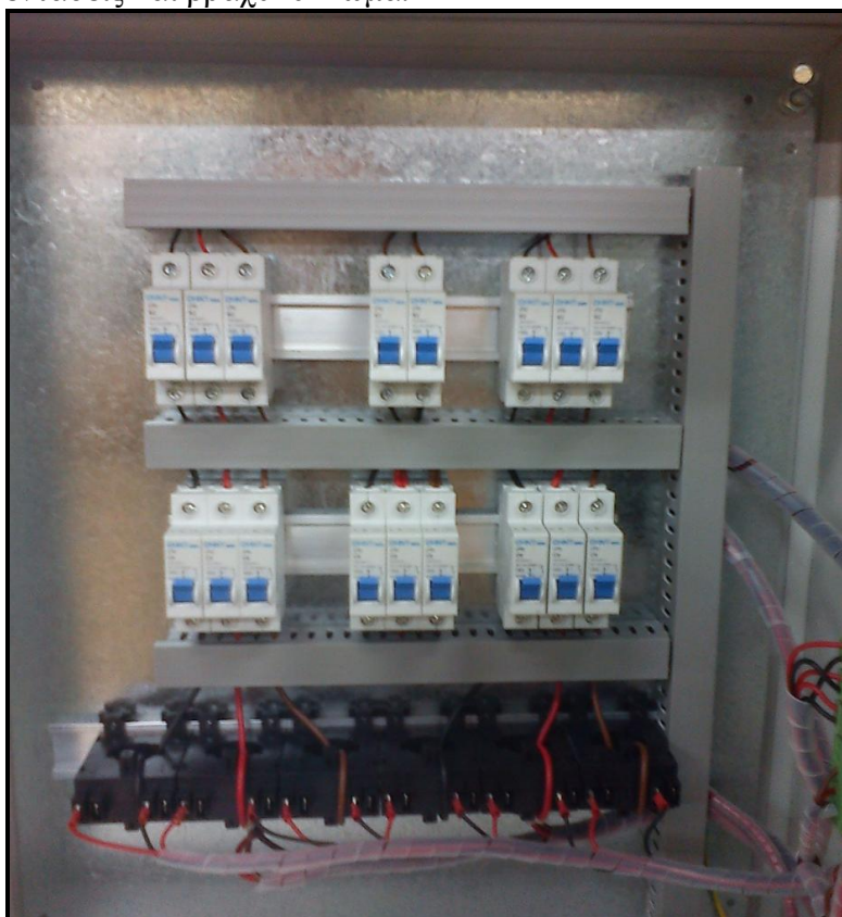
Σχήμα 4-8 Ασφαλειοδιακόπτης ράγας
