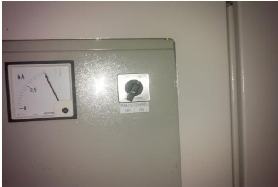
Εικόνα 5.4.14 Διακόπτης Remote Control.
