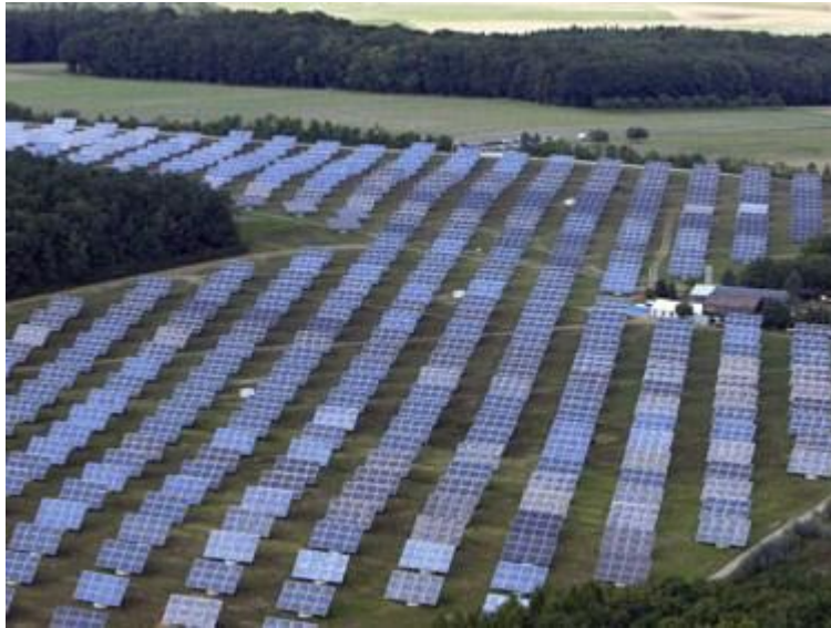
Εικόνα 1.2 Φωτοβολταϊκό πάρκο ισχύος 97,2KW στην Κοζάνη.
