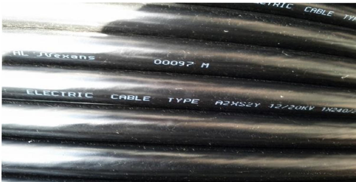
Εικόνα 5.4.5 Καλώδιο διασύνδεσης κάθε ομάδας Α/Γ με το αντίστοιχο πεδίο Μ.Τ.
