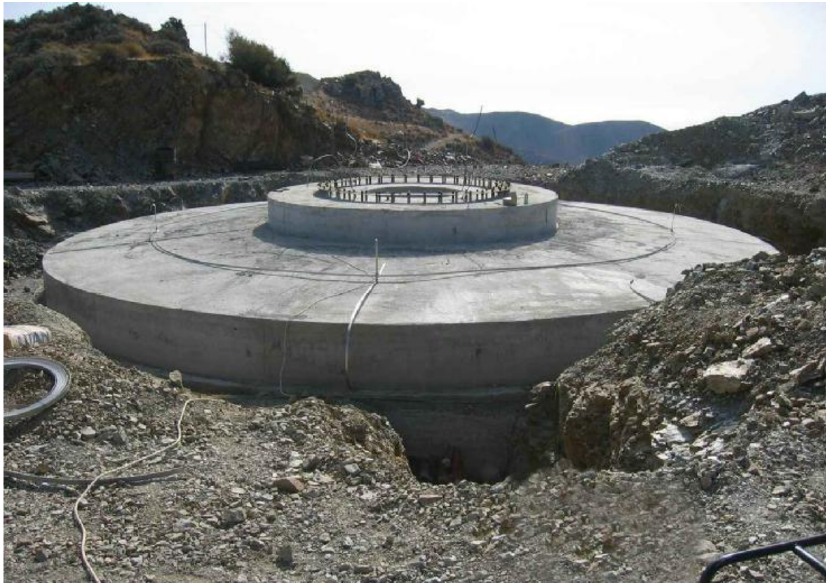
Εικόνα 5.5.4 Αναμονές της θεμελιακής γείωσης για την σύνδεση των αγωγών καθόδου.
