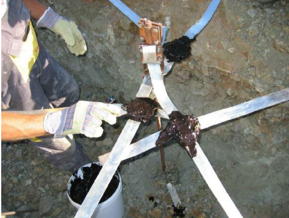
Εικόνα 5.5.1 Ταινίες γείωσης.
