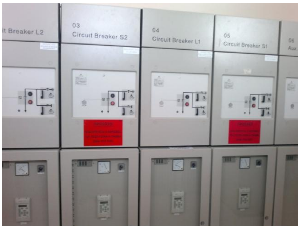
Εικόνα 5.4.11 Εμπρόσθιο μέρος πεδίων M.T.
