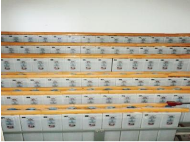
Εικόνα 5.4.19 Μπαταρίες τροφοδοσίας των UPS.
