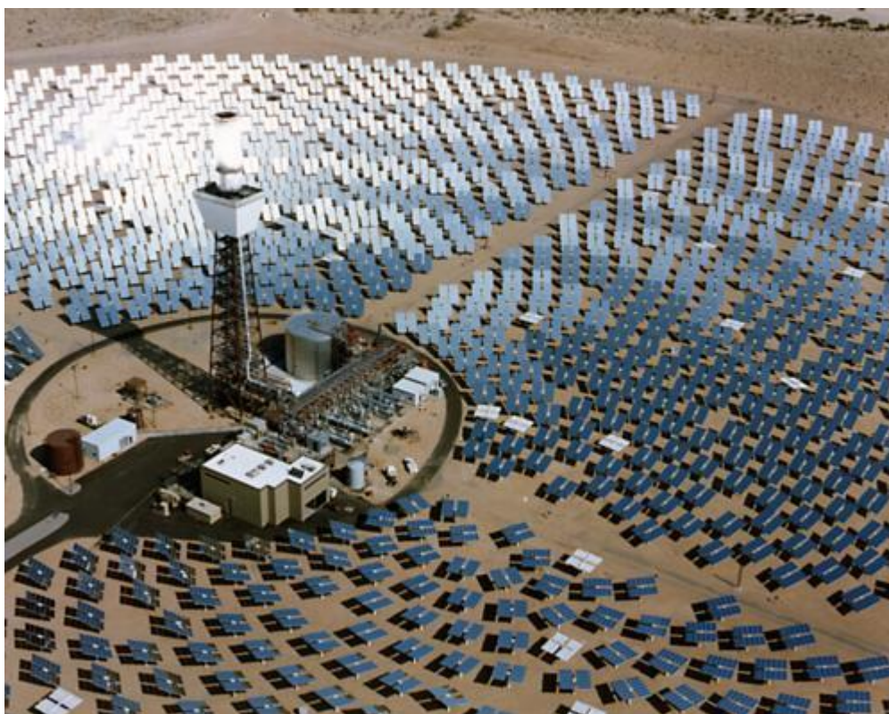
Εικόνα 1.1 Σταθμός παραγωγής ενέργειας 10 MW Barstow California.
