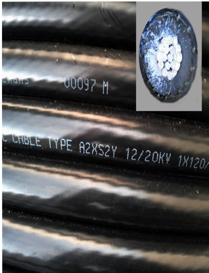
Εικόνα 5.4.1 Καλώδια σύνδεσης της Α/Γ με τον Μ/Σ.
