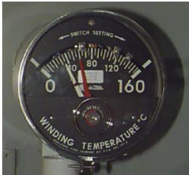
Εικόνα 1-14. Θερμόμετρο τυλιγμάτων. [5]
