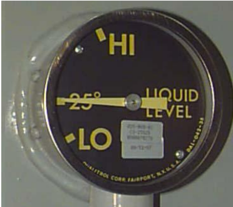
Εικόνα 1-16. Όργανο ένδειξης στάθμης λαδιού. [5]
