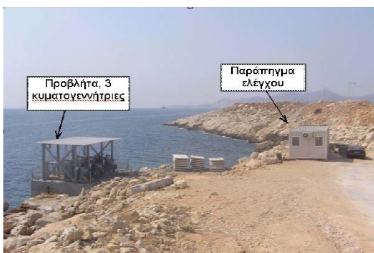
Σχήμα 3.5 Χωροταξική διεύθυνση του πειραματικού σταθμού παραγωγής ηλεκτρικής ενέργειας από θαλάσσιο κυματισμό στην Ψυτάλλεια. Πανοραμική άποψη της προβλήτας και του οικίσκου ελέγχου
