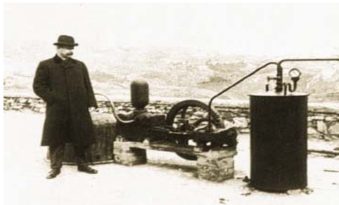
Σχήμα 1.2 Η μηχανή που χρησιμοποιήθηκε στο Larderello το 1904 κατά την πρώτη πειραματική απόπειρα παραγωγής ηλεκτρικής ενέργειας από γεωθερμικό ατμό. Διακρίνεται επίσης ο εφευρέτης της, πρίγκιπας Piero Ginori Conti.
