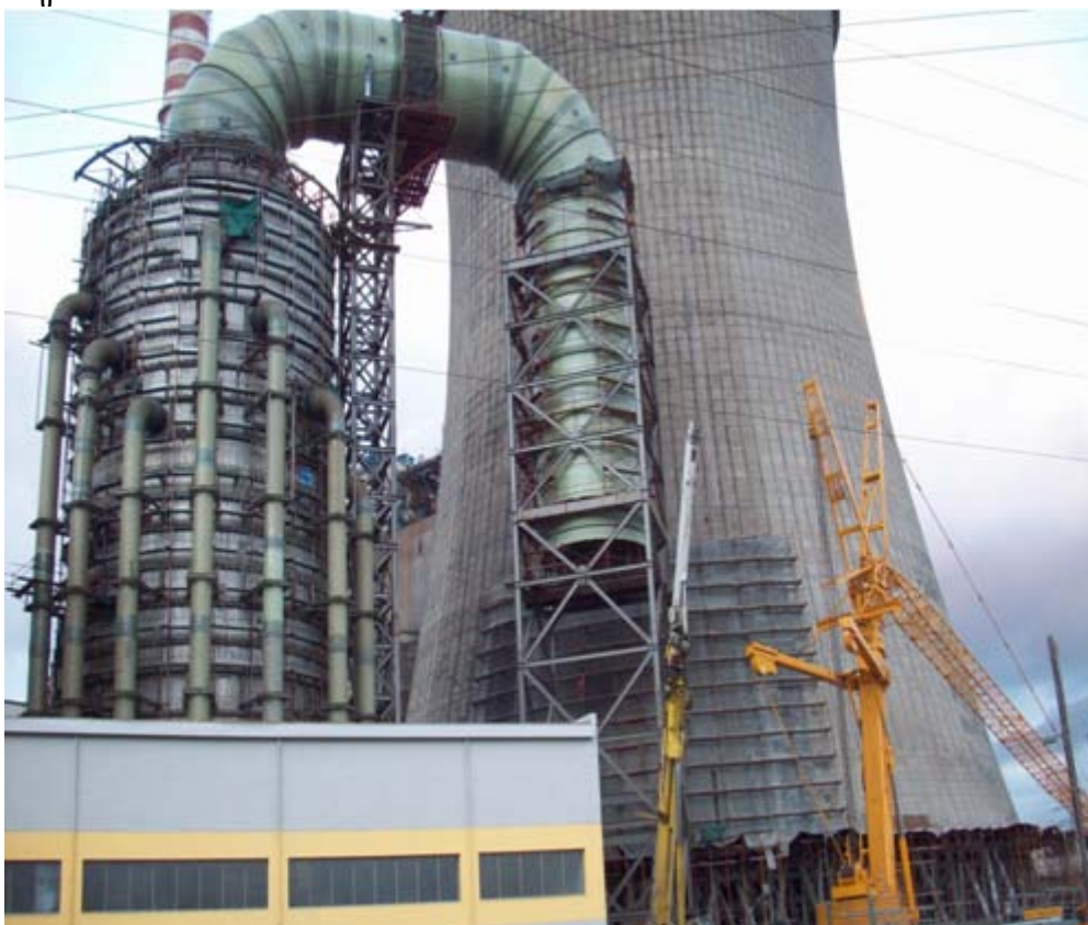
Σχήμα 8. Πύργοι ψύξεως μονάδας.
