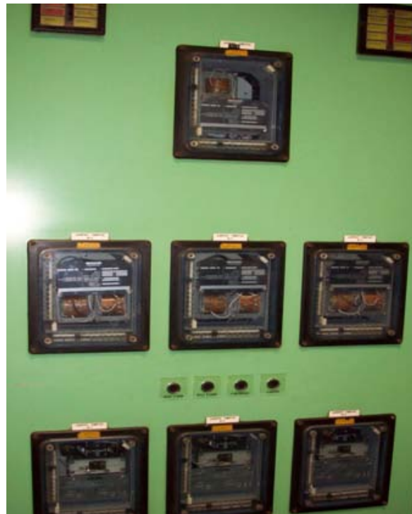
Σχήμα 48. Ηλεκτρονόμος 87T.
