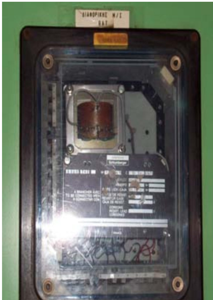
Σχήμα 44. Ηλεκτρονόμος διαφορικής γεννήτριας 87 G.
