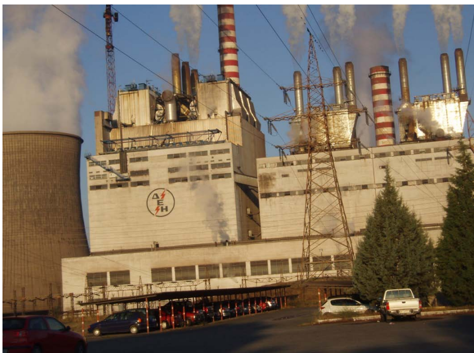
Σχήμα 1. Ατμοηλεκτρικός σταθμός ΑΗΣ Μεγαλόπολης.
