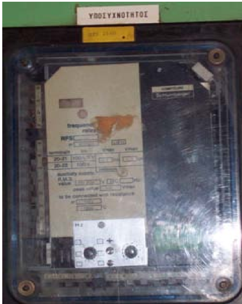
Σχήμα 36. Ηλεκτρονόμος υποσυχνότητας.
