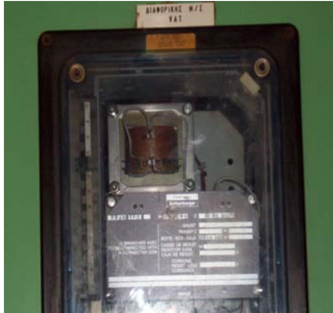
Σχήμα 46. Ηλεκτρονόμος γενικής διαφορικής 87 TG.
