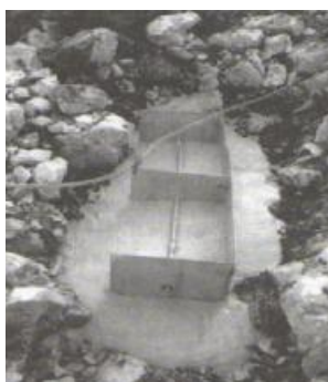
Εικόνα 3.9: Γειωτής «Ε» με βελτιωτικό TERRAFILL
