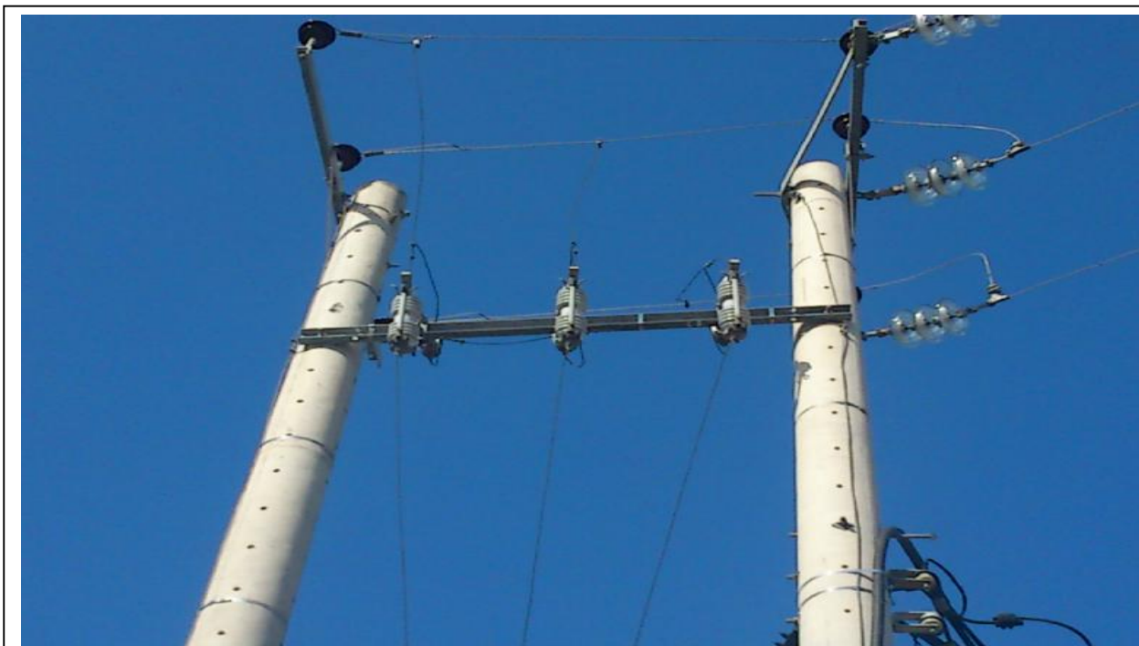
Εικόνα 3.2 ΑΣΦΑΛΕΙΕΣ ΣΕ ΔΙΑΚΛΑΔΩΣΗ
